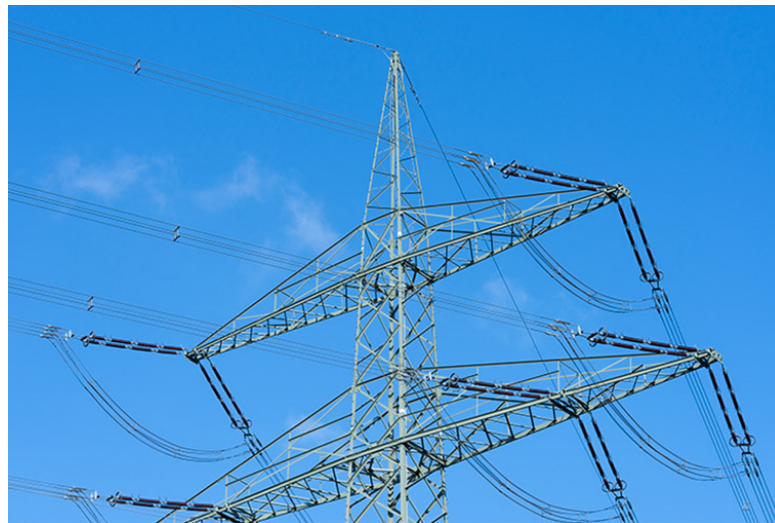
Figura 10 – Estrutura de Ancoragem.
