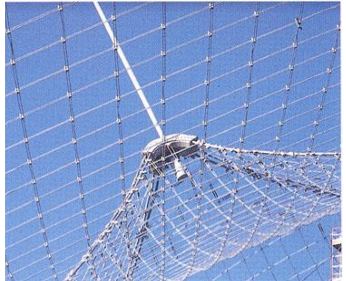
Figura 37 - Cabos de apoio para os painéis de plexiglass
