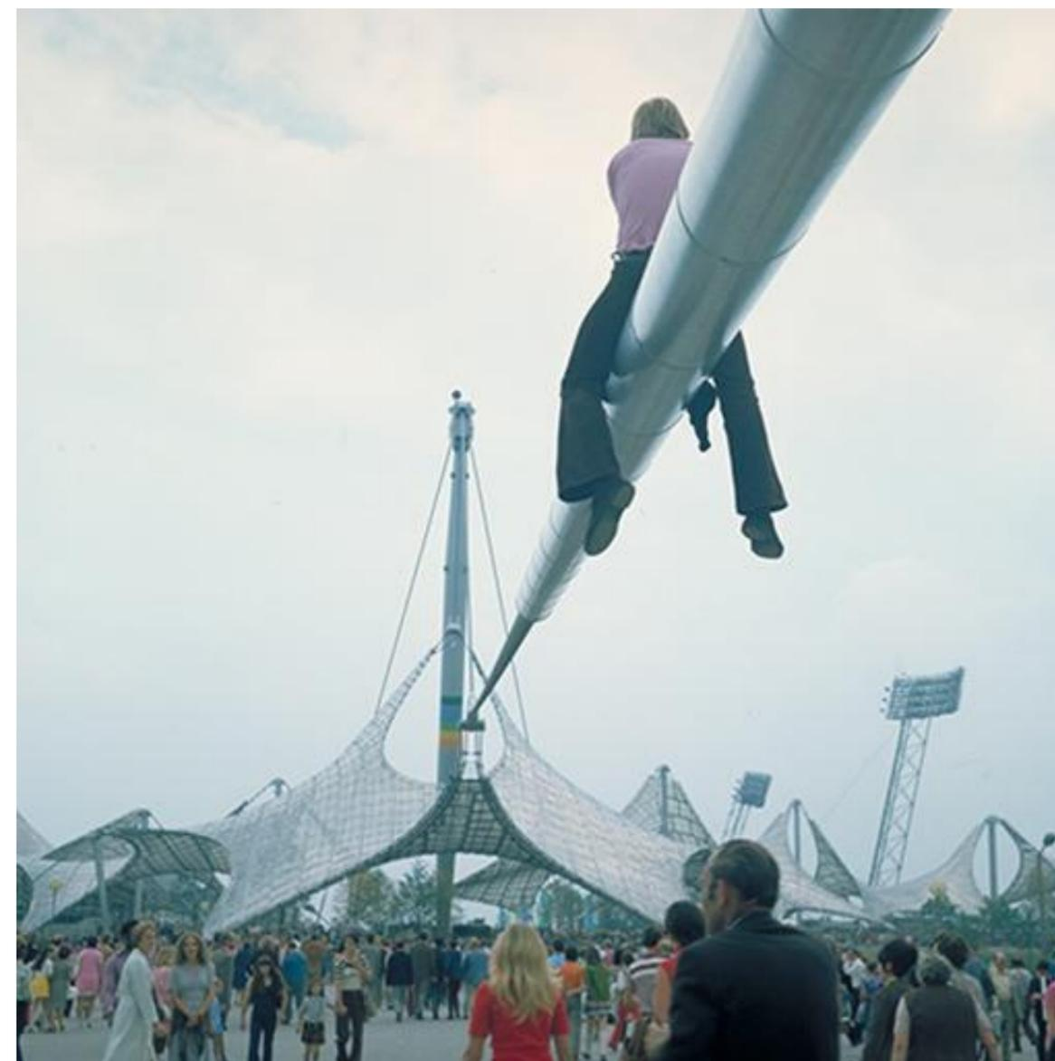
Figura 42 - Vista da cobertura e de um dos principais cabos tensionados da estrutura
