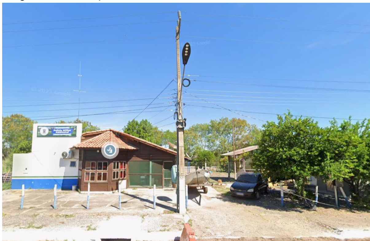
Figura 5 – Posto avançado da PMA-MS no Buraco das Piranhas
