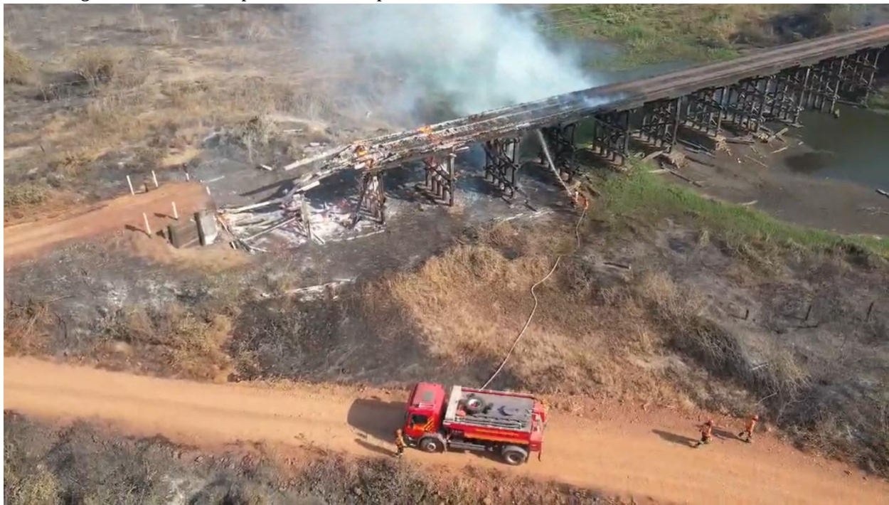
Figura 12 Incêndio em ponte de madeira provoca isolamento de comunidades no Pantanal - TIF 2024
