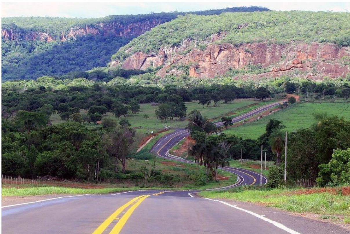
Figura 03: O caminho foi pavimentado, entre os distritos de Piraputanga a Camisão
