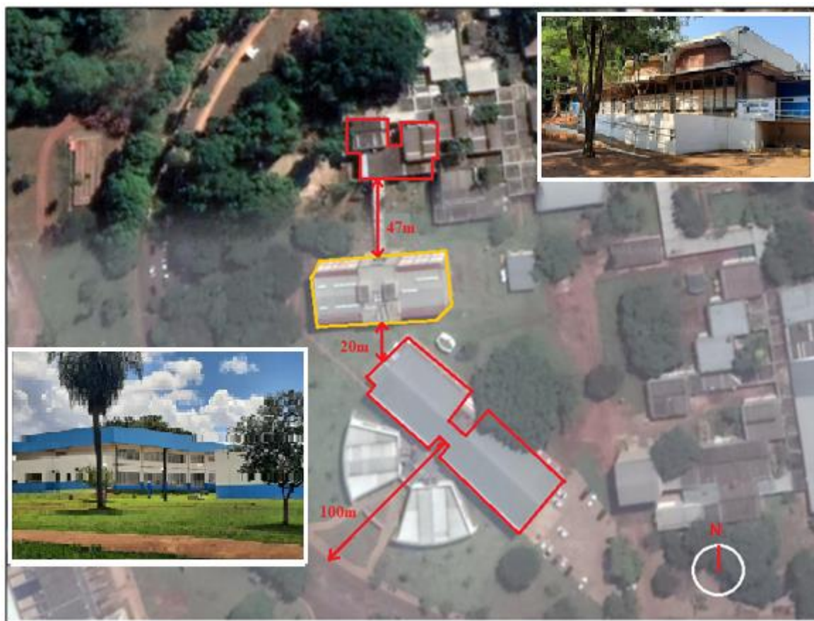
Figura 9. Localização das salas dos Ateliers da Arquitetura (à direita) e das salas do Complexo Multiuso (à esquerda) /UFMS. Com distâncias das edificações do entorno imediato e a indicação do local dos experimentos.
