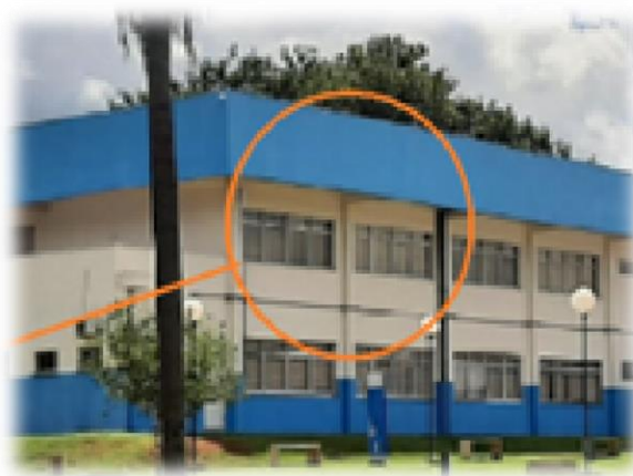
Figura 22. imagem externa Sala 11 – Oeste.
