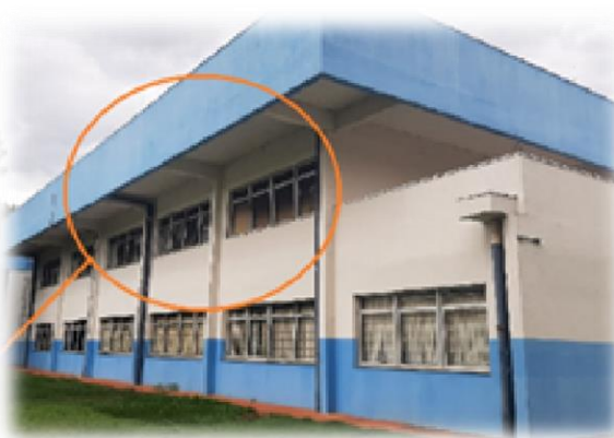
Figura 25. imagem externa Sala 12 – Leste
