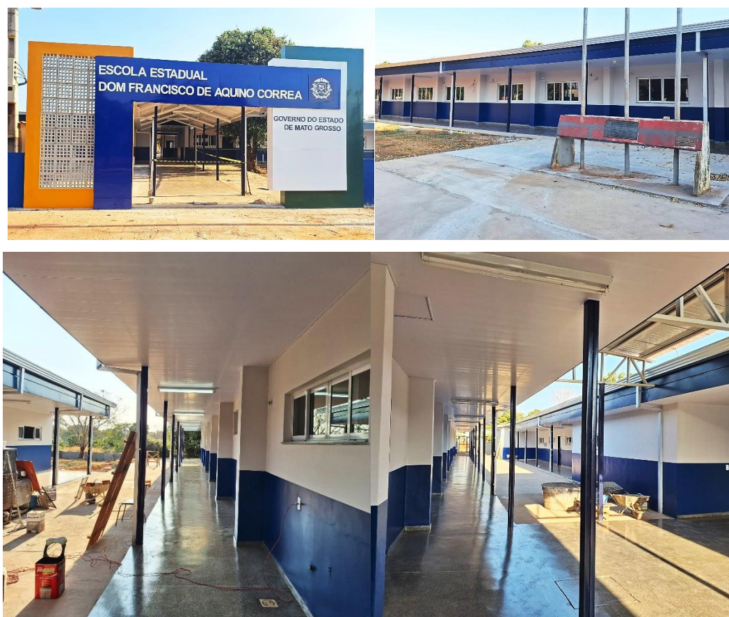
Figura 18: Prédio reformado da escola Dom Francisco de Aquino Corrêa no fim do ano de 2024.
