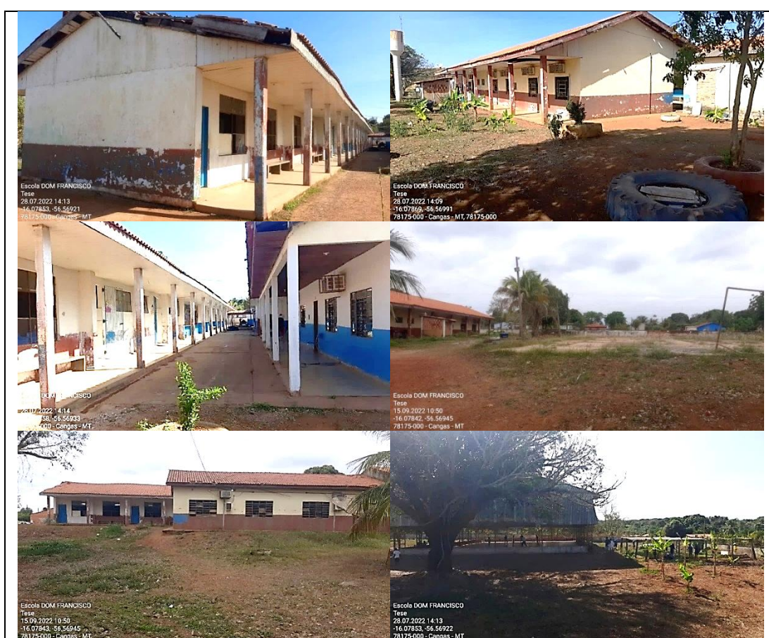
Figura 15: Sede da escola antes da reforma
