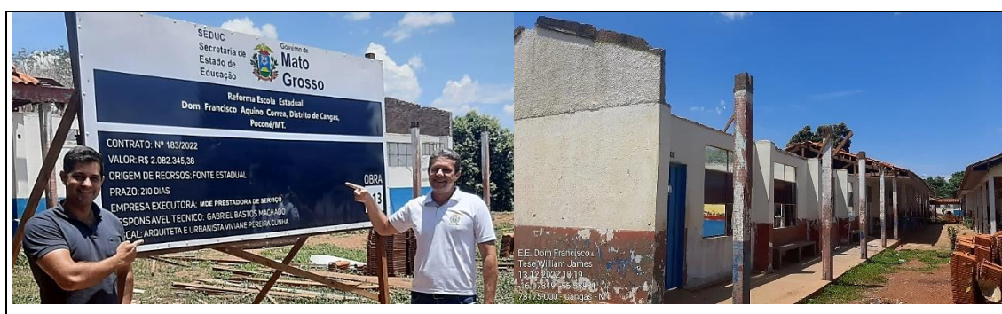
Figura 16: Sede da escola com reforma iniciada
