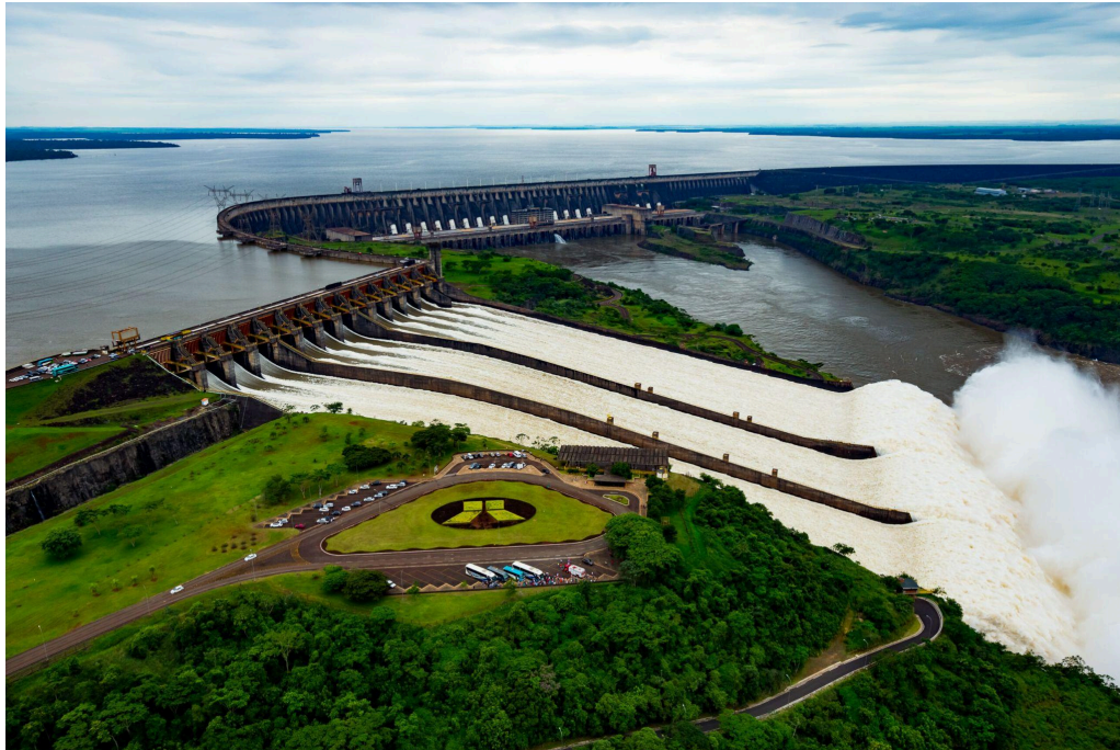
Figura 12. Usina hidrelétrica de Itaipu em Foz do Iguaçu, PR. Retirado de “Turismo Itaipu” https://turismoitaipu.com.br/a-usina-itaipu/ . Acesso em 15/06/2026.
