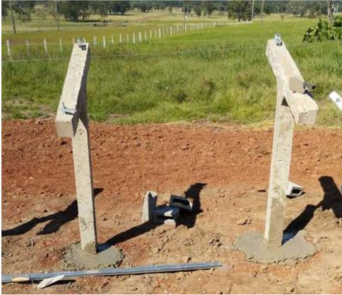
Foi dado um prazo de 72 horas para a cura do concreto enquanto realizávamos as demais atividades necessárias para a execução da usina e após esse tempo começamos o posicionamento dos módulos.
