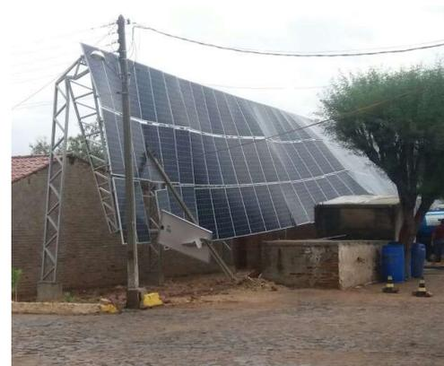
Figura 4 – Desabamento de placas fotovoltaicas instaladas em cobertura metálica. Fonte: Canal Solar.
