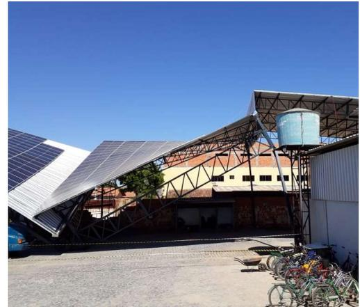
Figura 3 – Desabamento de estrutura para placas fotovoltaicas. Fonte: ShareEnergy.
