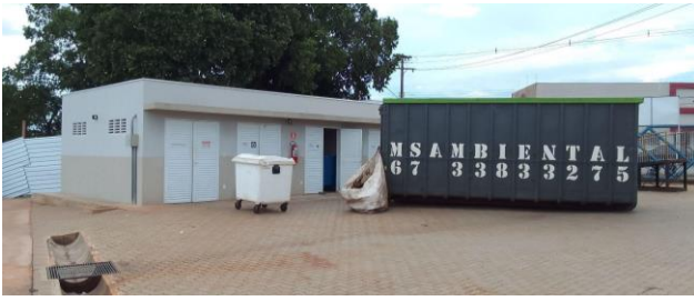
Figura 6 – Abrigo temporário de RSS. Fonte: Autor.
