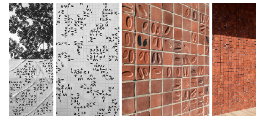
Figura 29 - Revestimento com mosaico de cerâmica nas paredes do projeto de alojamento da U. Mpumalanga
