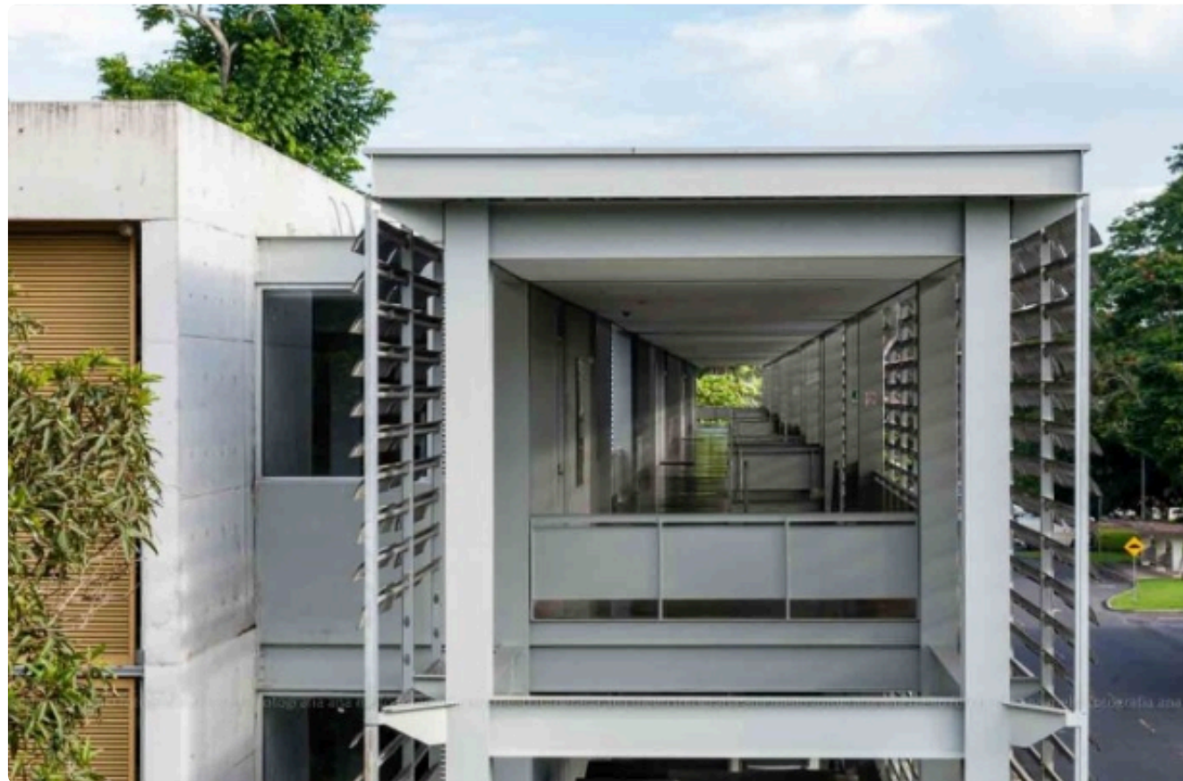
Figura 15 – Vista lateral corredor pavilhão metálico de circulação
