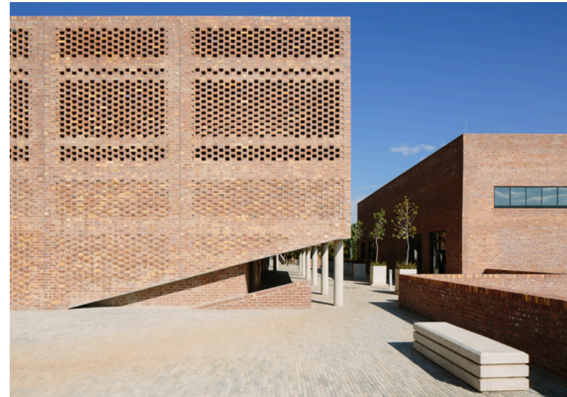
Figura 26 - Telas formadas pela técnica construtiva de parede de tijolos vazados
