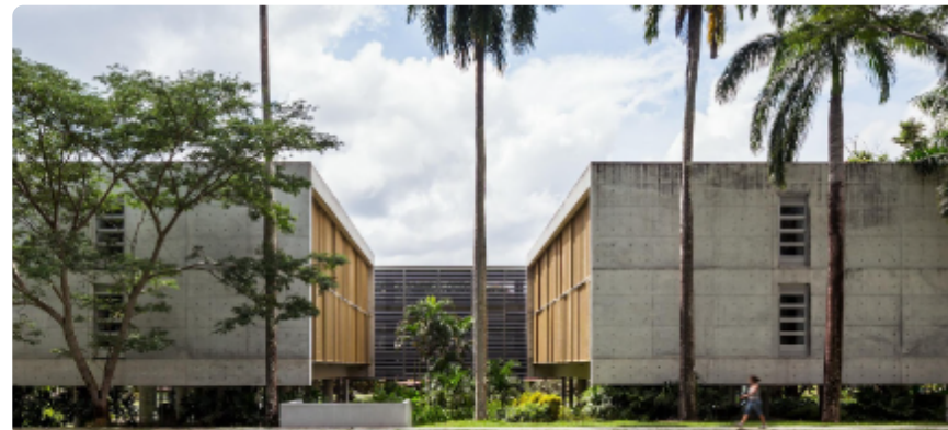
Figura 11 - Visão interna do pátio entre os blocos dos dormitórios da ciudad del saber
