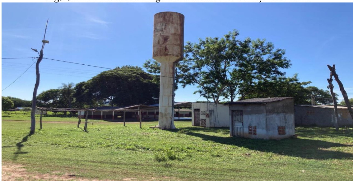
Figura 22: Reservatório d'água da Comunidade e Praça de Bomba
