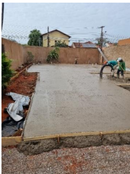
Figura 28: Radier durante a Concretagem
