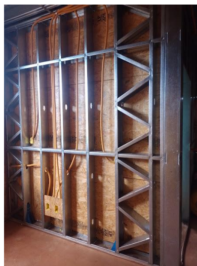
Figura 30: Pannel reticulado na Obra
