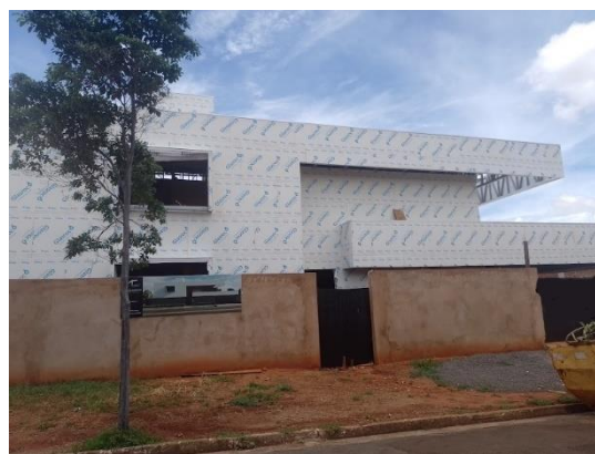
Figura 44: Revestimento externo com Placa Glassmat
