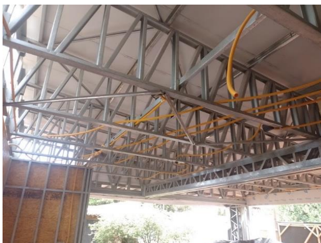
Figura 41: Cobertura durante a execução
