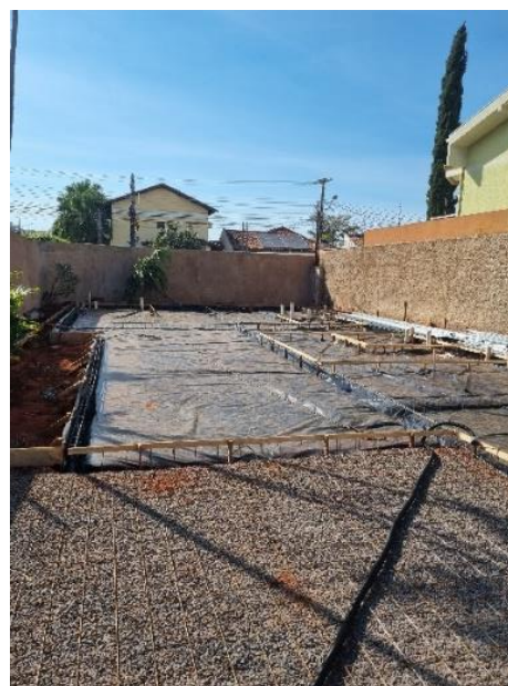
Figura 27: Radier antes da Concretagem
