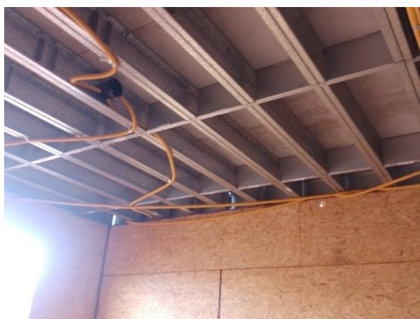
Figura 37: Laje Mista– vista inferior
