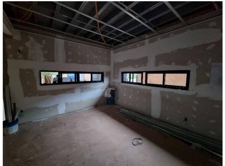
Figura 47: Revestimento interno com placa de gesso
