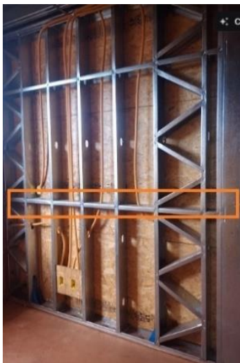
Figura 32: Bloqueador aplicado no painel
