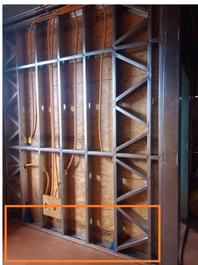
Figura 33: Aplicação da Guia no Painel reticulado
