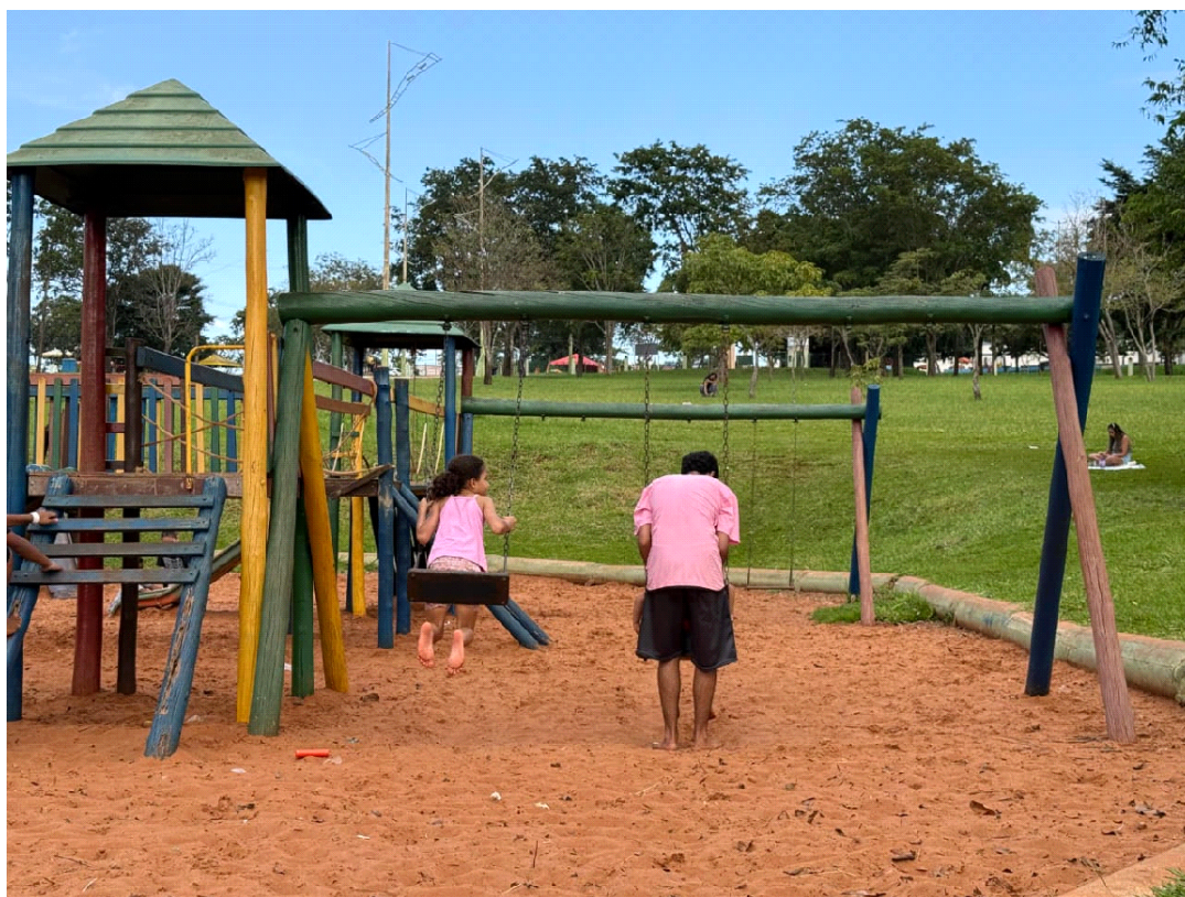
Brinquedos desgastados e sem manutenção comprometem a segurança das crianças nos parquinhos infantis. Foto: Gabriela Almeida
