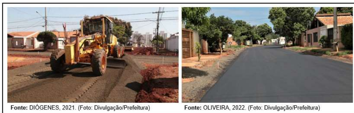
Figura 10: Pavimentação asfáltica das vias públicas do Bairro Rita Vieira.
