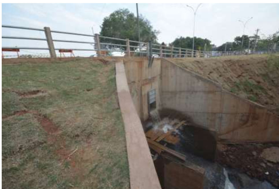
Foto 2: Vertedouro Emergencial instalado no Lago do Amor - 2023
