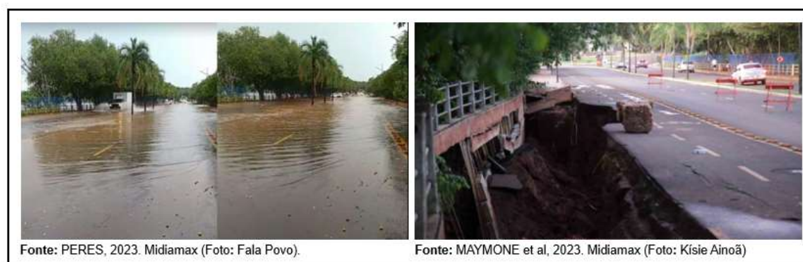
Figura 17: Evento de Inundação na Av. Filinto Muller, 08/03/2023 2 , Lago do Amor.
