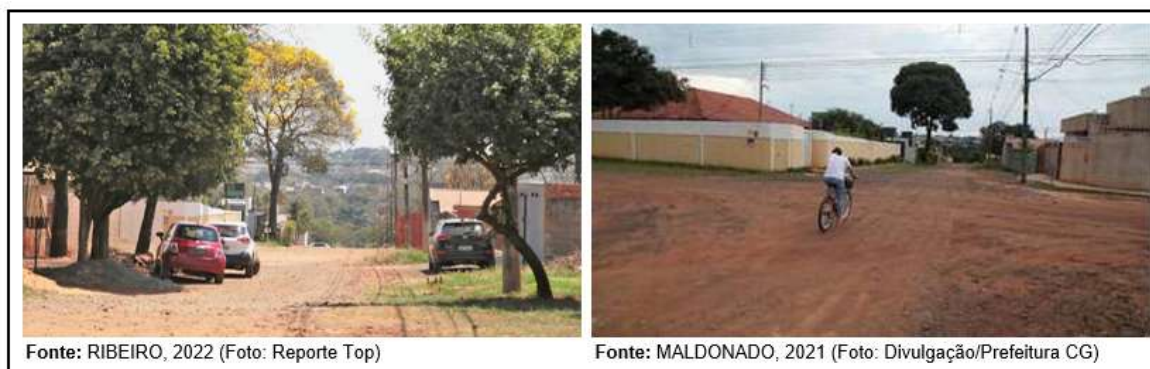
Figura 7: Vias públicas sem pavimentação do bairro Rita Vieira em 2021.
