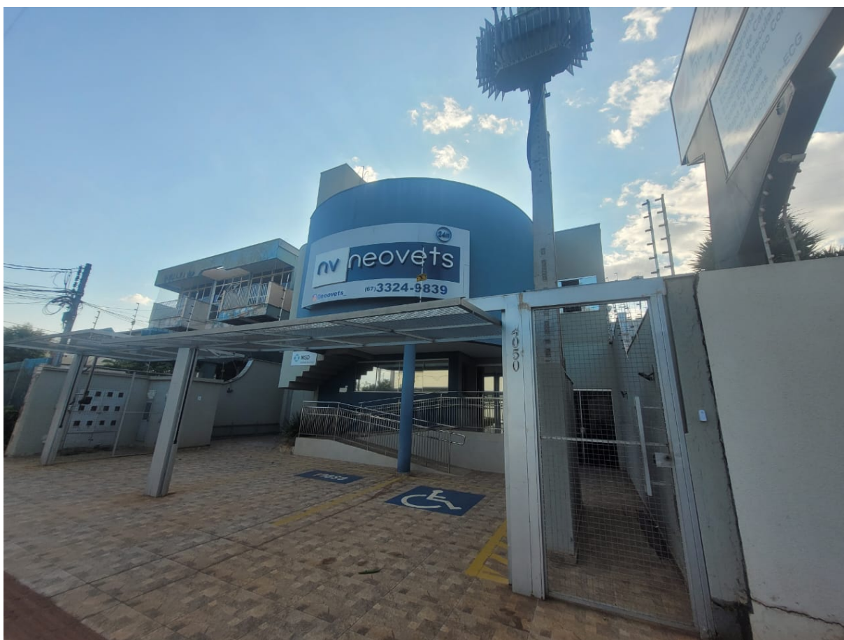
Figura 1 - Fachada da clínica veterinária NEOVETS.
