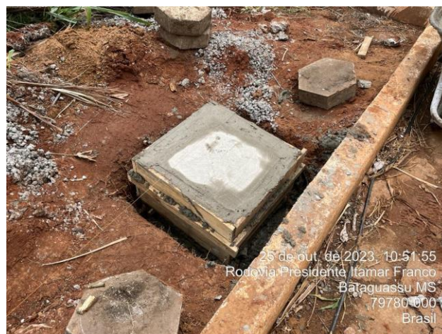
Figura 17 – Fundação de blocos de concreto.
