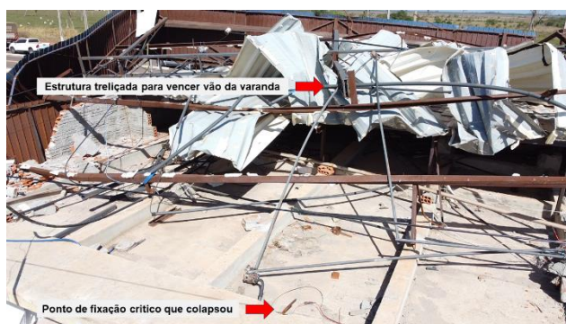
Figura 06 – Estrutura treliçada.
