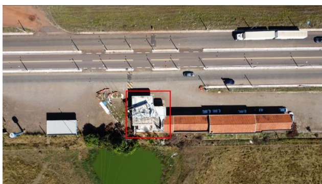
Figura 02 – Vista área da estrutura colapsada.
