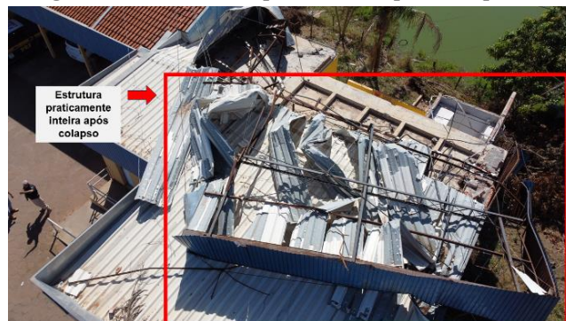
Figura 04 – Estrutura preservada após o impacto.
