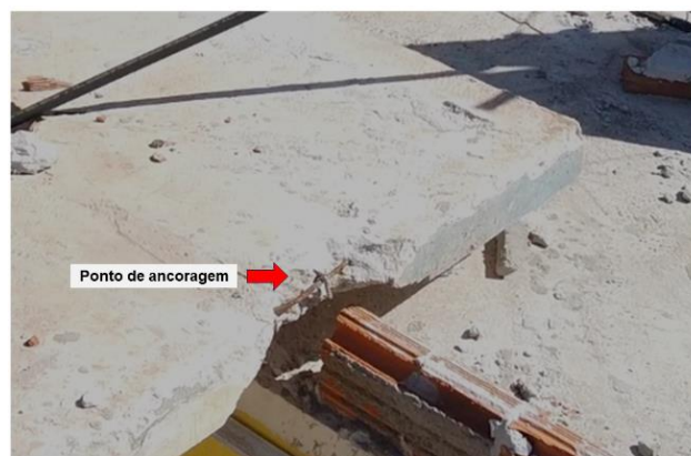
Figura 09 – Ponto de ancoragem.
