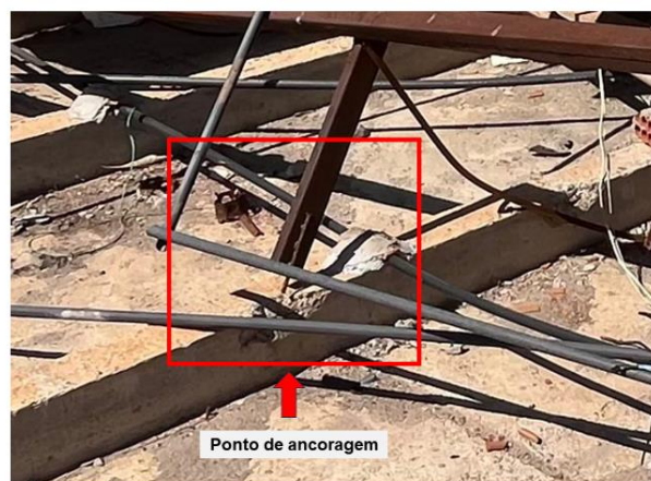
Figura 05 – Ponto de ancoragem.
