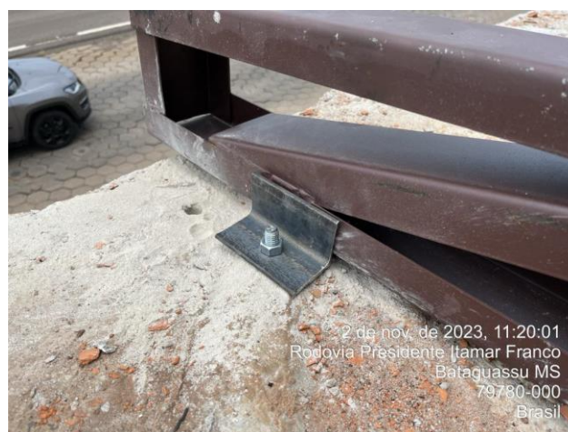
Figura 13 – Ancoragem sobre laje
