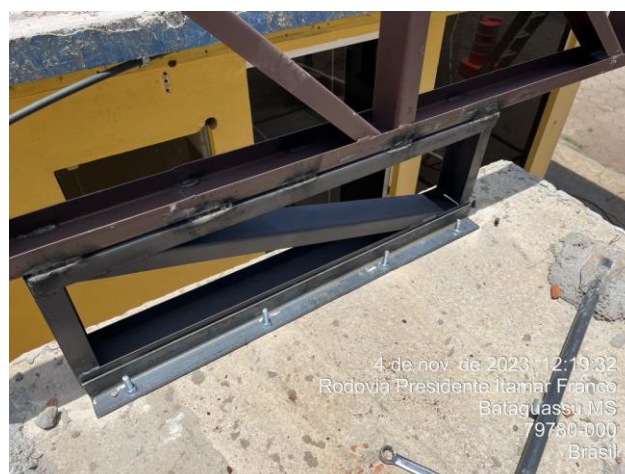
Figura 14 – Ancoragem sobre laje.
