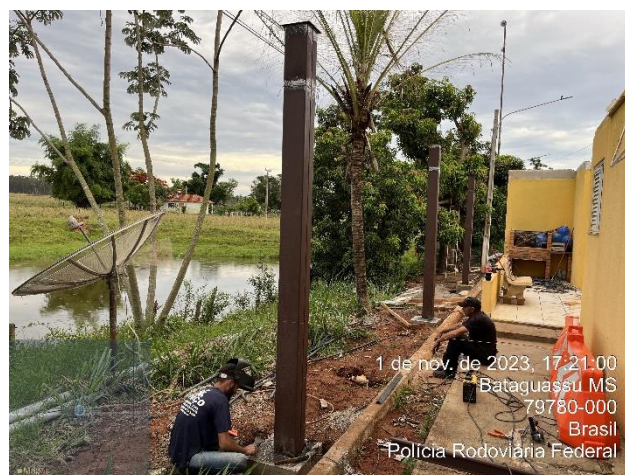
Figura 18 – Soldagem dos pilares nos blocos de concreto.
