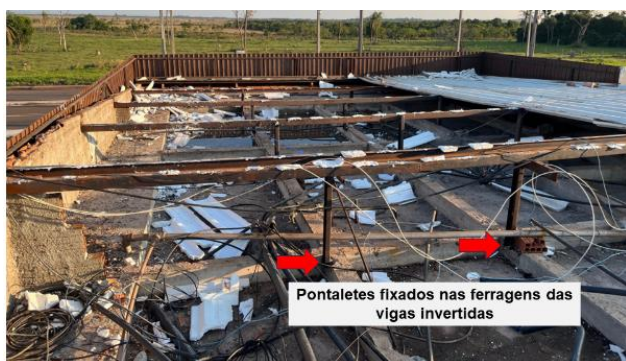
Figura 07 – Pontaletes metálicos.
