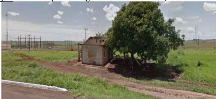
Figura 26: Subestação de energia da fazenda Itamarati. (novembro de 2011)
