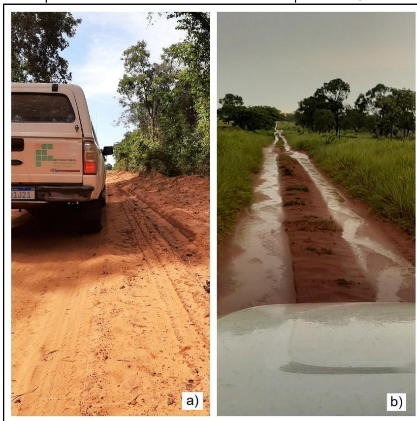
Figura 35 – Evidências de campo do processo erosivo decorrentes da geometria e da segregação dos agregados. a) Bermas na lateral da pista próximo a UA23; b) Facão com escoamento direcionado para trilhas de roda em estrada encaixada próxima à UA1
