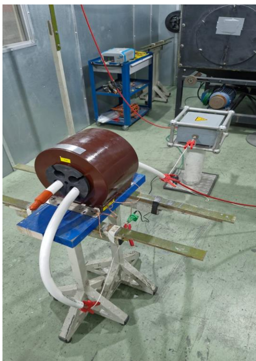
Figura 8- Montagem dos elementos para ensaio de DP (TC, Bucha EPDM, Cabos, Capacitor de Acoplamento, HV FILTER 150/5, Garras de conexão de aterramento e fases).
