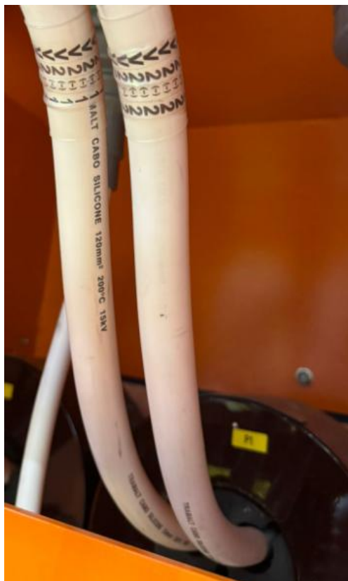
Figura 13- Cabo TRAMALT com bitola de 120 mm 2
