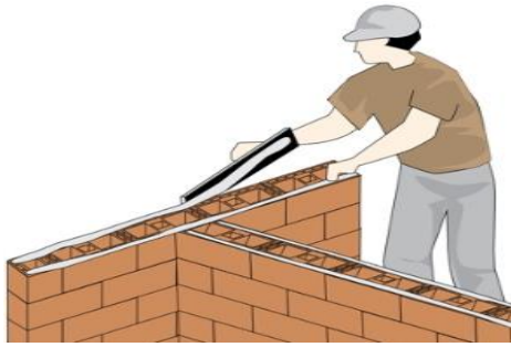
Figura 6 – Aplicação de argamassa com palheta. Fonte: https://engenharia360.com
