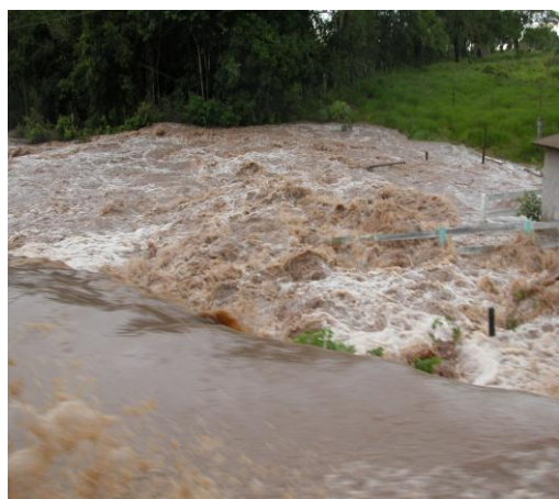
Figura 17 - Talvegue do córrego Beleza após rompimento de açudes à montante (maio/2006)
