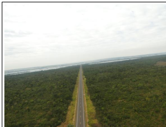
Figura 54 – Vista da Rodovia Br 158, que passa pela área da Reserva Cislalina
