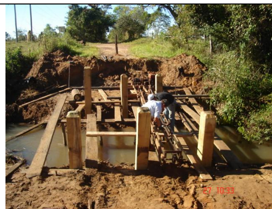
Figura 20 – Construção de nova ponte no córrego Beleza (junho/2006)
