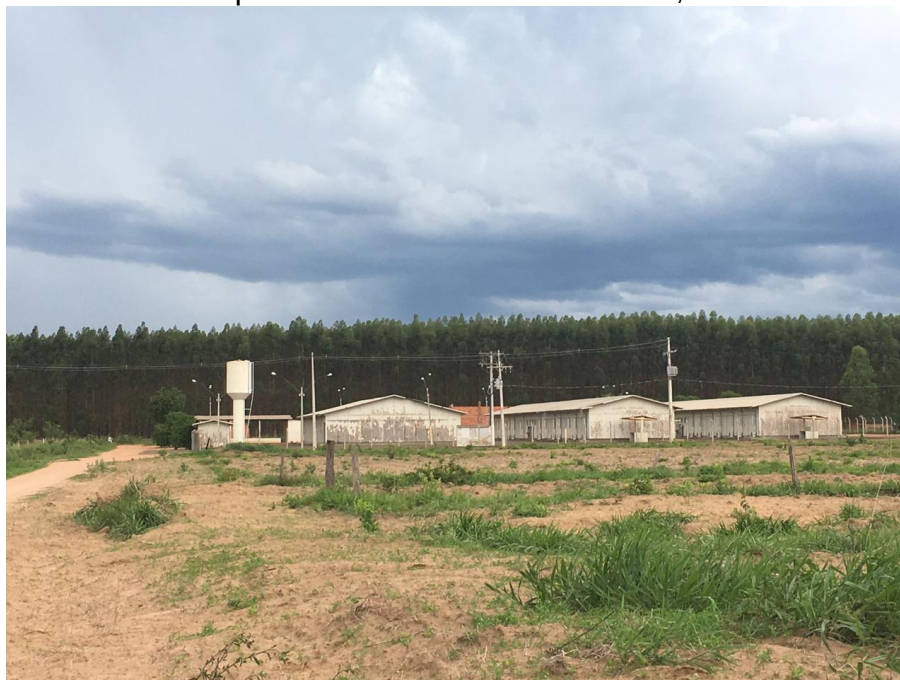
Figura 22 - Distrito da Véstia: terreno do Loteamento Guadalupe do Alto Paraná - Alojamento construído em parte da área da chácara nº 21, destinada a área verde
