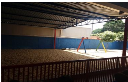
Figura 3: Caixa de areia coberta
