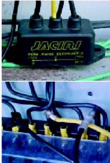
Figura 1.12– Exemplo de desvio na chave de aferição
