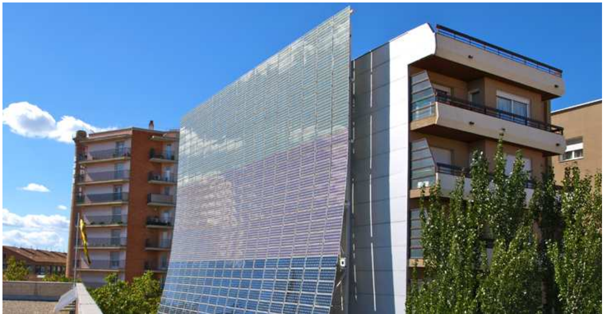
Figura 8 – Painéis aplicados nas fachadas de edifícios.
