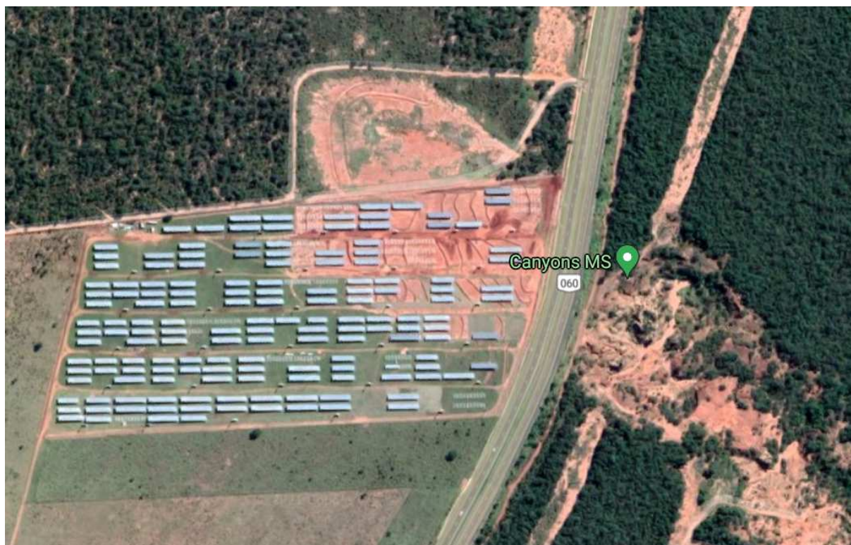
Figura 13– Usina de Geração Fotovoltaica – Campo Grande/MS.
