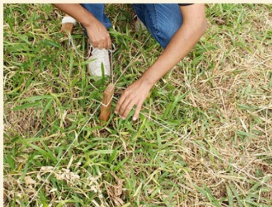
Figura 10: Fixação de estacas. Fonte: Os autores
