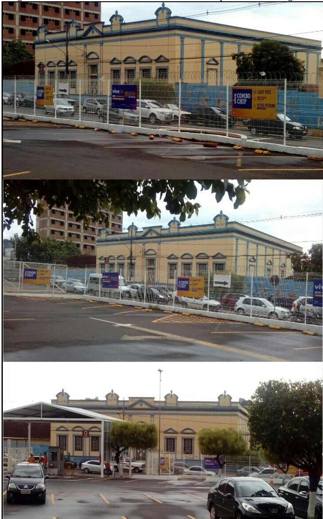
Figura 10 - Parte do estacionamento do Mercado Municipal cercado e com guarita.
