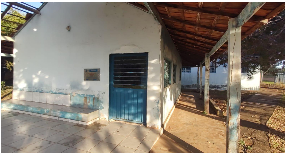
Figura 27 - Prédio do antigo Posto de Saúde
