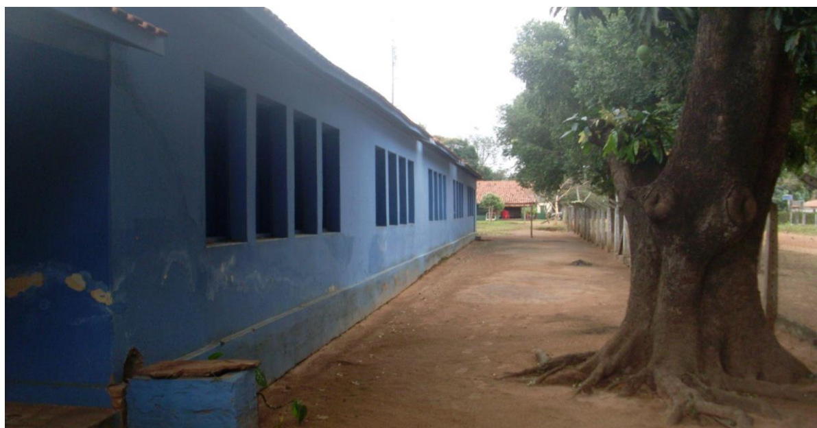
Figura 20 - Vista parcial do pátio da Escola Municipal Visconde de Taunay
