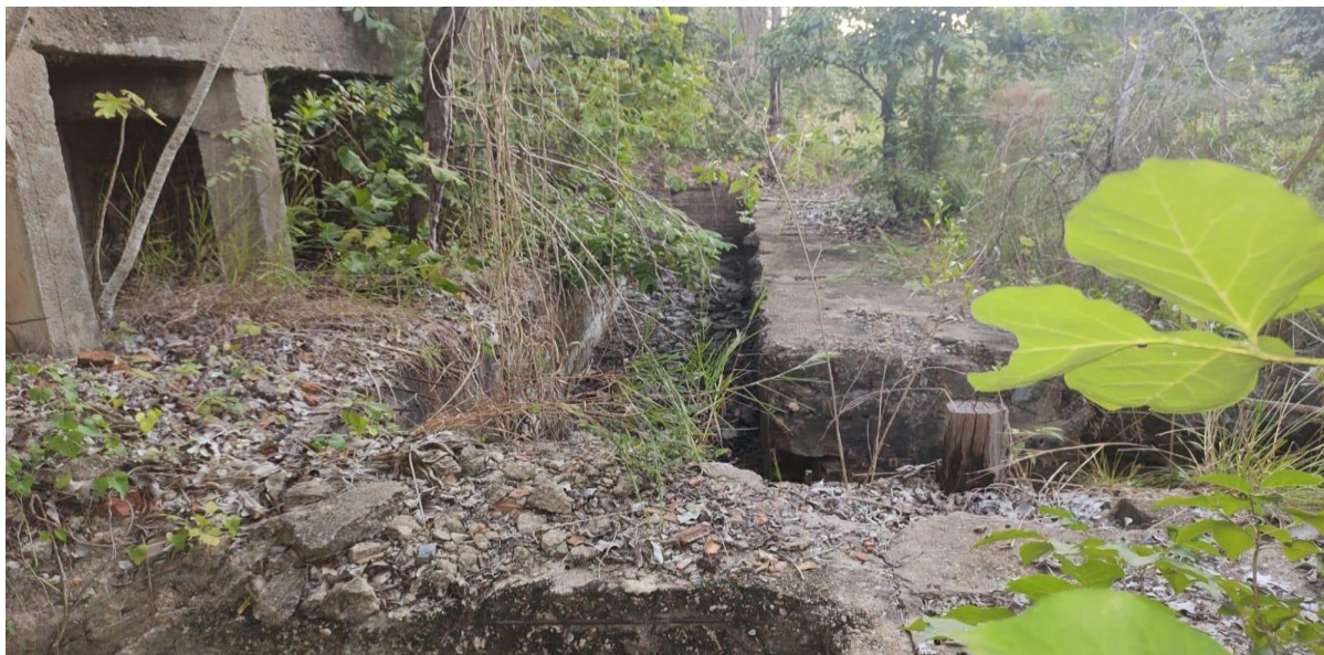
Figura 5 - Base da estrutura de concreto da empresa Calcário Aquidauana
