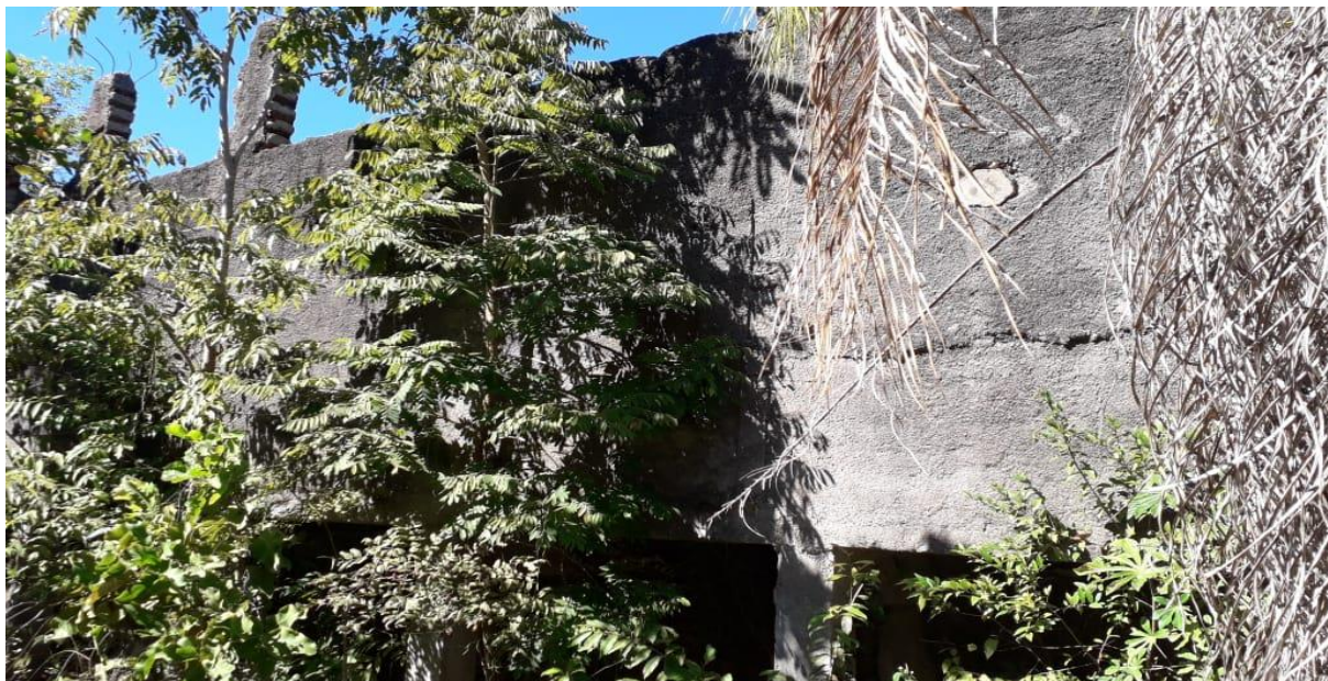
Figura 14 - Estrutura de concreto da Empresa de Calcário – Ano 2019
