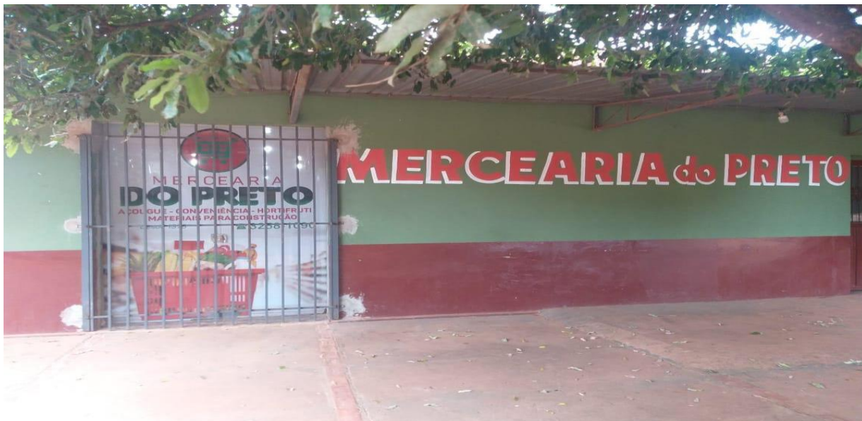
Figura 32 – Prédio de Atividade Comercial Varejista
