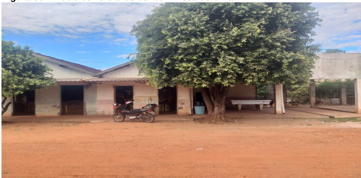
Figura 36 – Prédio comercial de bar com mesa de bilhar
