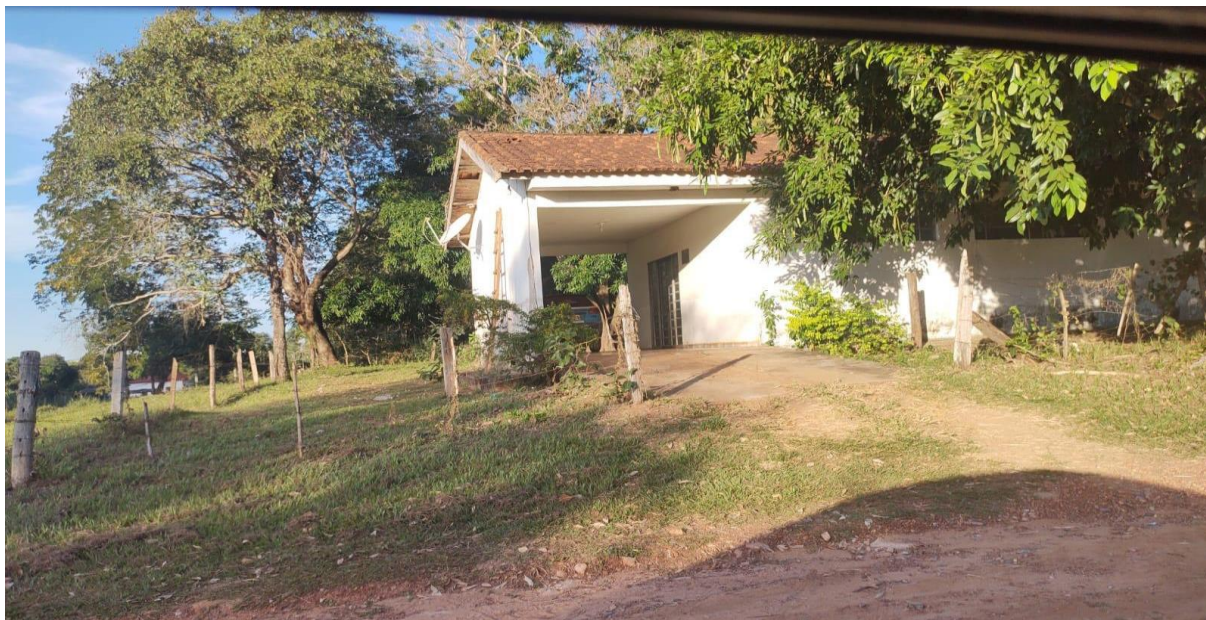
Figura 29 - Prédio do Posto da Polícia Militar – Rua Estevão Alves Corrêa
