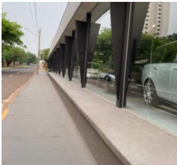
Figura 36 - Exemplo de adaptação das construções nas áreas vulneráveis. Fundações mais altas que o nível da calçada. Dos autores.
