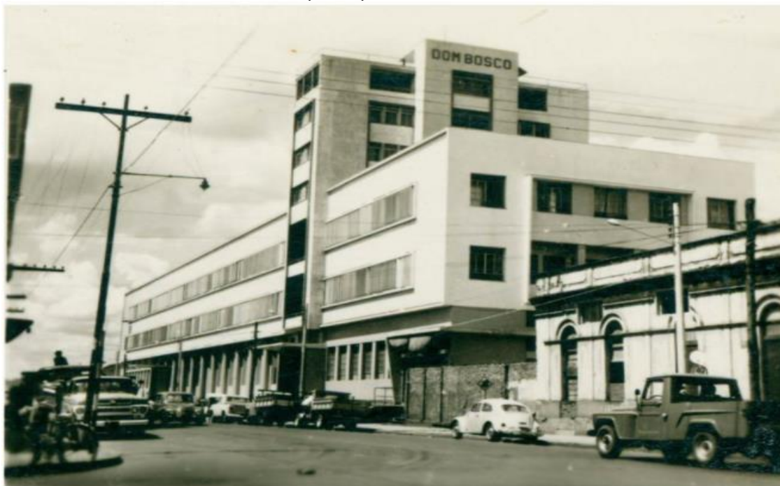
Figura 3 - Colégio Dom Bosco local da primeira instituição de nível superior de Mato Grosso do Sul, FADAFI (1996)
