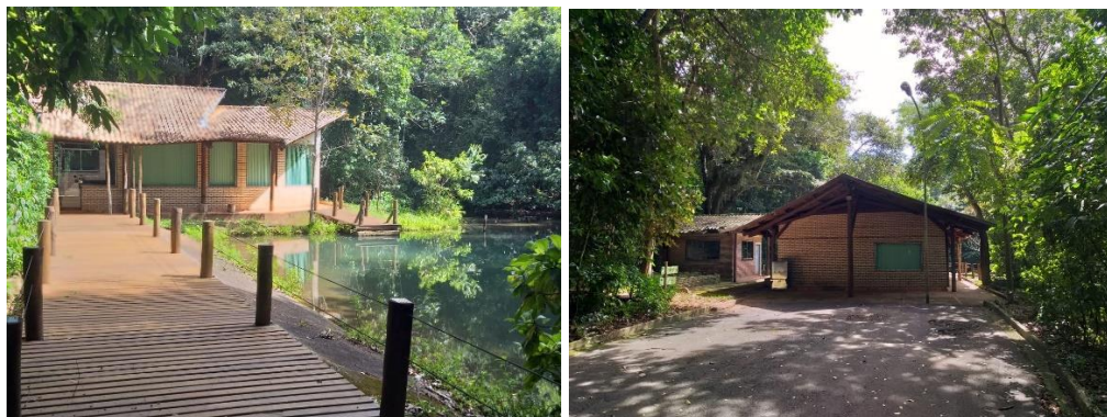
Figuras 11 e 12. Centro de Visitantes (auditório)
