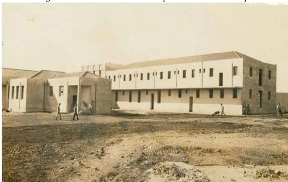
Figura 1 – Presídio Central de Campo Grande em Construção
