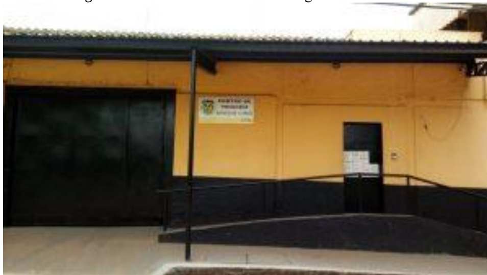
Figura 18 – Fachada do Centro de Triagem “Anísio Lima”
