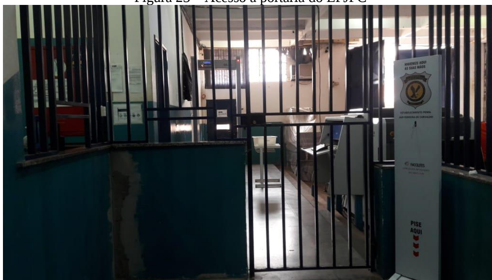
Figura 23 – Acesso à portaria do EPJFC
