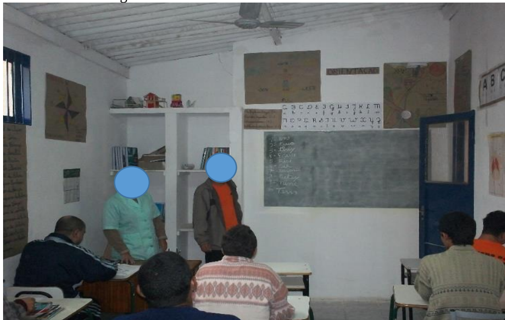
Figura 19 – Sala de Aula CTAL antes da reforma
