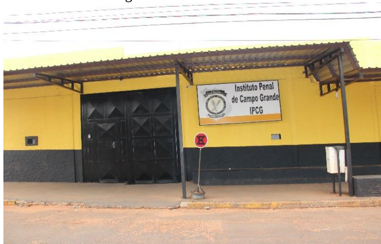
Figura 9 – Fachada do IPCG
