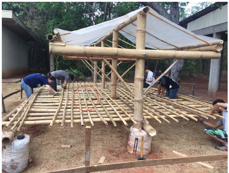
Emende para alcanzar 6m, con alambre o abrazadera de plástico. Empiece del medio para los bordes.
