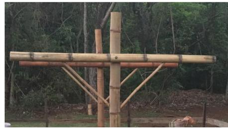
Diagonales fijadas con tornillos.
