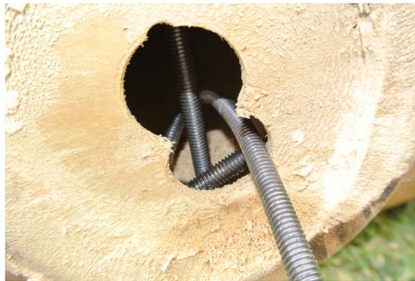
**3º PASO:** perfore el vástago C, y monte un "U" invertido conectándola con A y B. Fije con varillas roscadas 1/4", tuercas, contratueras, anillos de hule y huachas.
