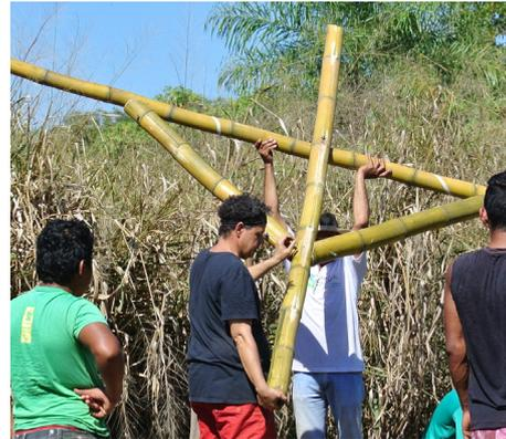
Diagonales fijadas con varilla roscada.
