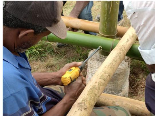
La viga central debe ser presa a los pilares en cruz, utilizando varillas roscadas, tuercas, contratuercas, anillos de hule y huachas.
