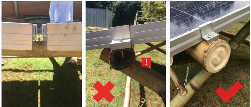
! Es el momento de colocar los tapones de bambú, si alguna extremidad quedó expuesta. Utilice una punta con nudo, con diámetro igual al diámetro interno de la vara a ser tapada. Fijar con tornillos.
