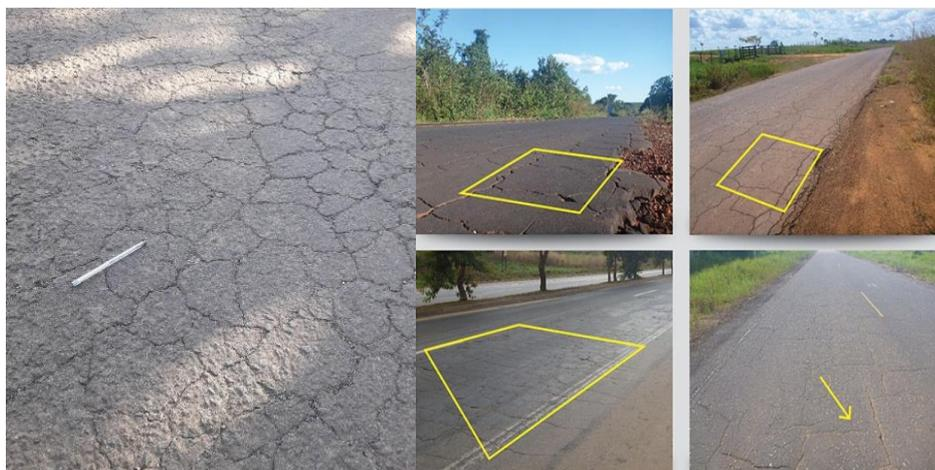
Figura 3 – Trincas de fadiga “Couro de Jacaré” (esq.) e “Bloco” (dir.).
