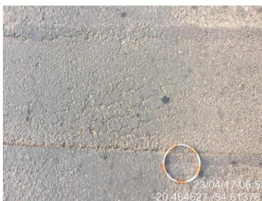
Figura 4 – Foto de desgaste do pavimento (inicial).
