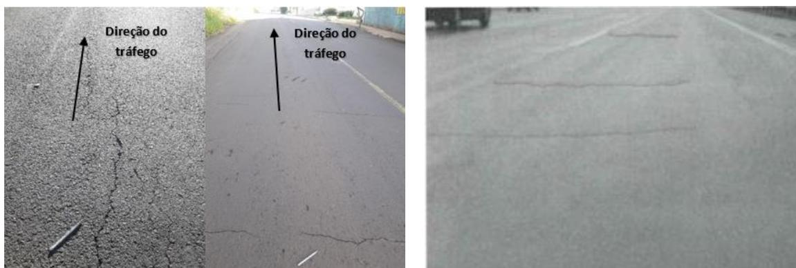
Figura 2 – Trinca longitudinal (à esq.), transversal (meio) e de retração (à dir.).
