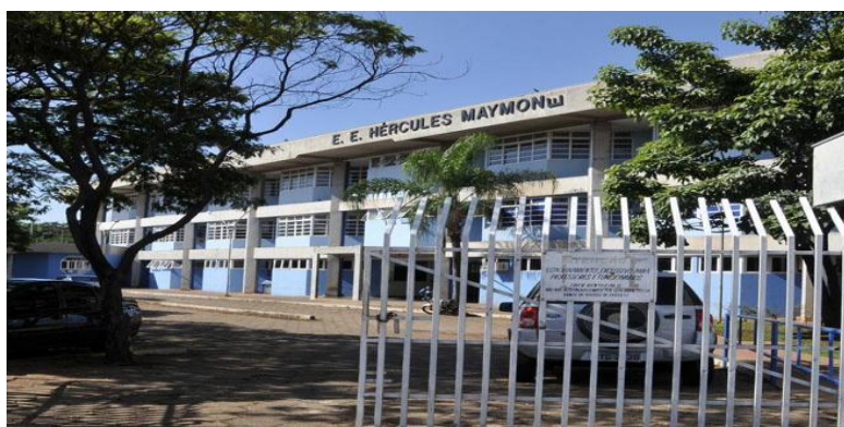
Figura 7 - Escola Estadual Hércules Maymone: prédio construído para receber em definitivo o IECG, inaugurado em 1992.
