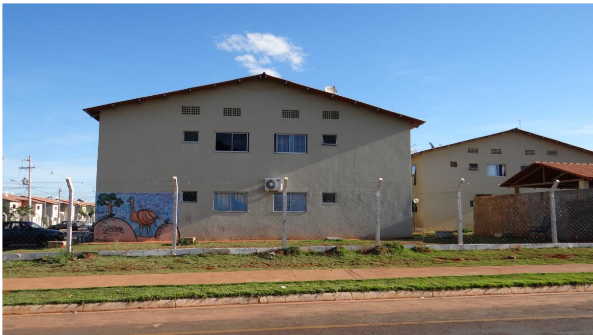
Figura 10. Imagem lateral do Condomínio Ema.
