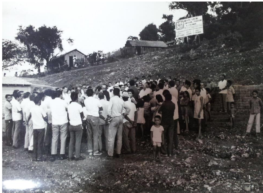
Figura 7 – Local de lançamento da construção da TV Cidade Branca. Corumbá, MS.
