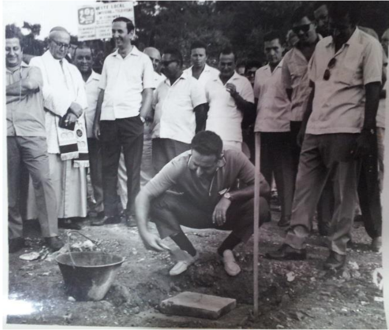
Figura 6 - Pedra fundamental da TV Cidade Branca. Corumbá, MS*.
