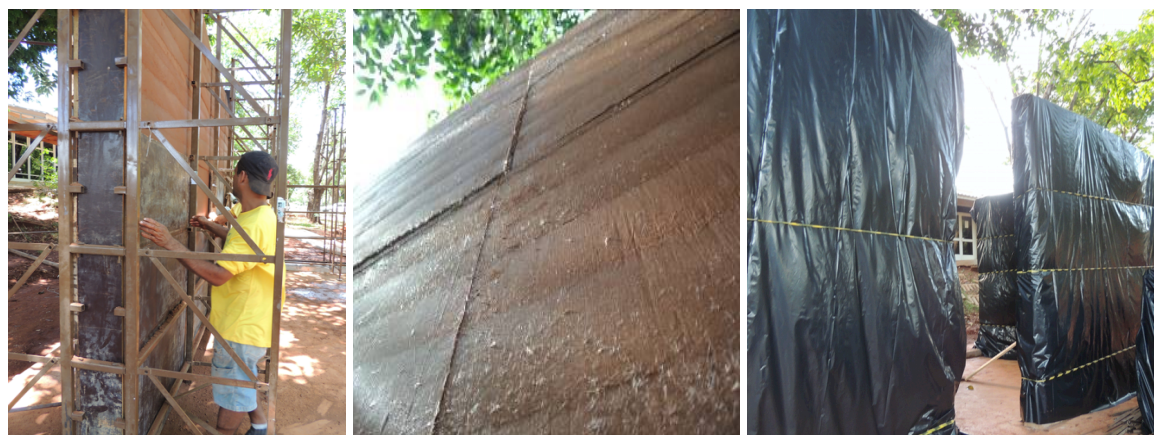
(a) Retirada das chapas de compensado
