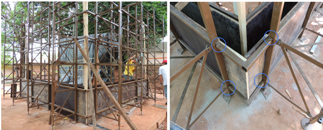
(c) Parede “L”: montagem do 1º lance de chapas (d) Encaixe com pinos e conexões de canto (“L”)
