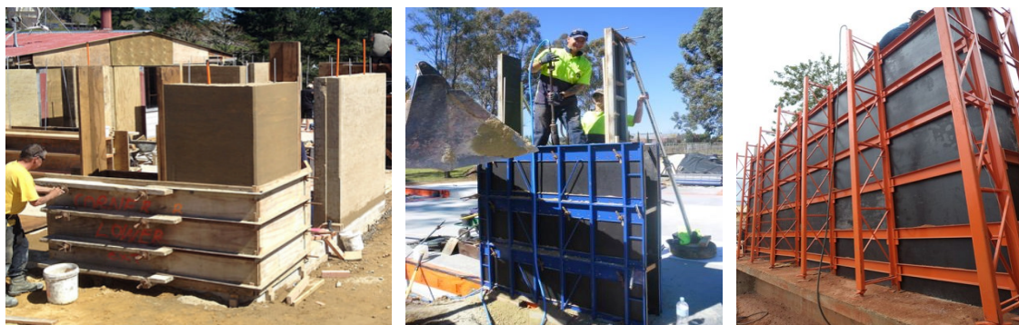
(a) Chapas laminadas 21mm reforçadas com tábuas; (b) Alumínio com parafusos; (c) Aço sem parafusos
