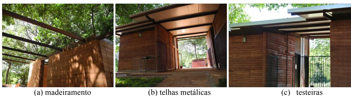
Figura 32. Cobertura metálica do protótipo de habitação.
