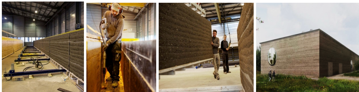
Figura 5: Pré-fabricados de taipa mecanizada usados em Ricola Herb Center, Suíça
