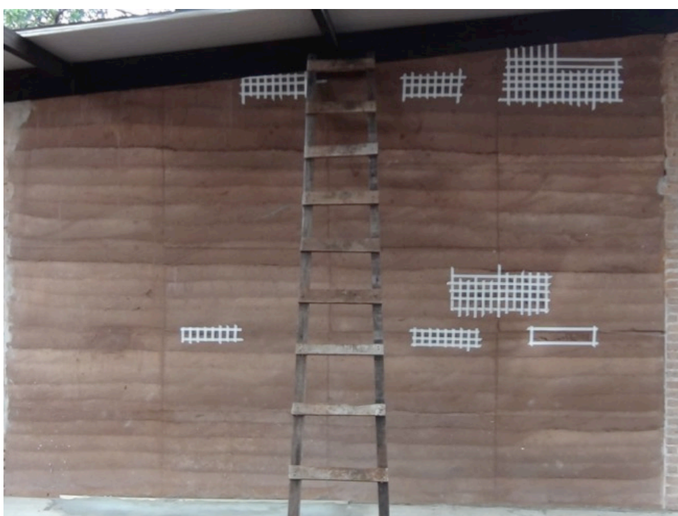
(b) montagem das malhas de fita crepe sobre arrancamentos
