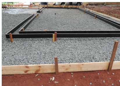
(a) caixaria do radier e baldrame
