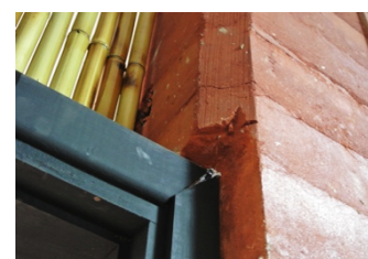
Parede pós-desbaste
