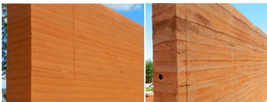
Figura 7: Parede A (esquerda) e parede B (direita), ambas com compactação pneumática
