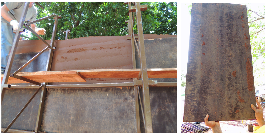
Figura 23: Material que aderiu na forma durante a desforma
