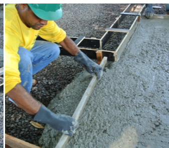
(b , c) concretagem do radier e do baldrame da parede
