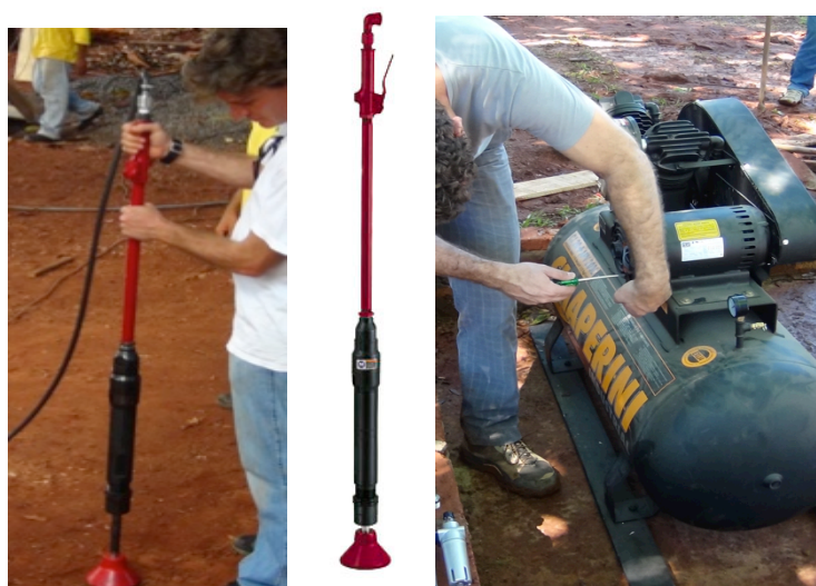
Figura 49: Compactador pneumático e compressor
