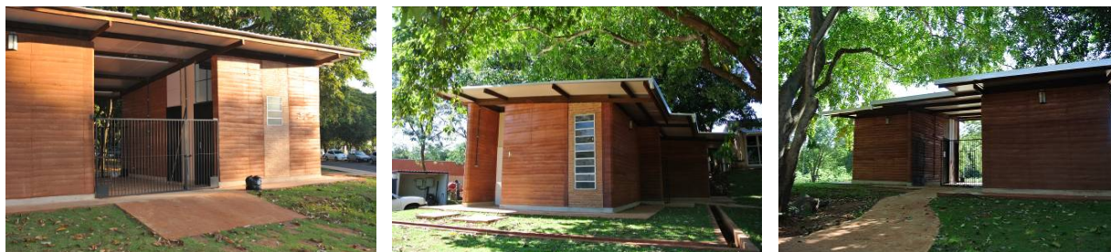
Figura 26. Protótipo de habitação na UFMS
