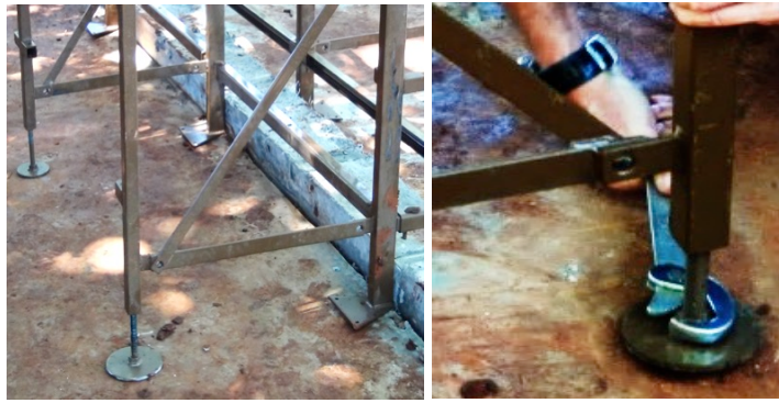
(a) Parafusamento das treliças no radier (b) Pé-rosqueável
