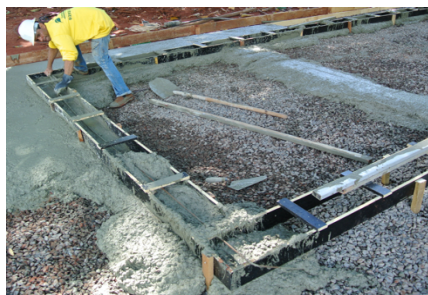
(b , c) concretagem do radier e do baldrame da parede
