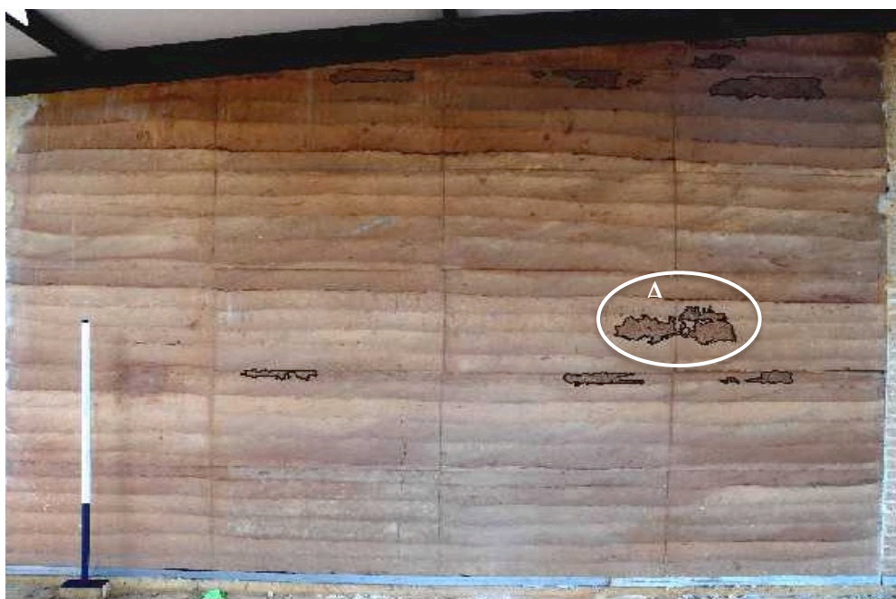
(a) perímetro desenhados em cad, sobre imagem, sendo destacado o arrancamento A.
