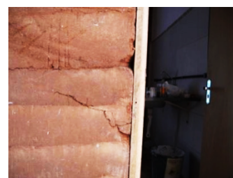
Parede pós-desbaste
