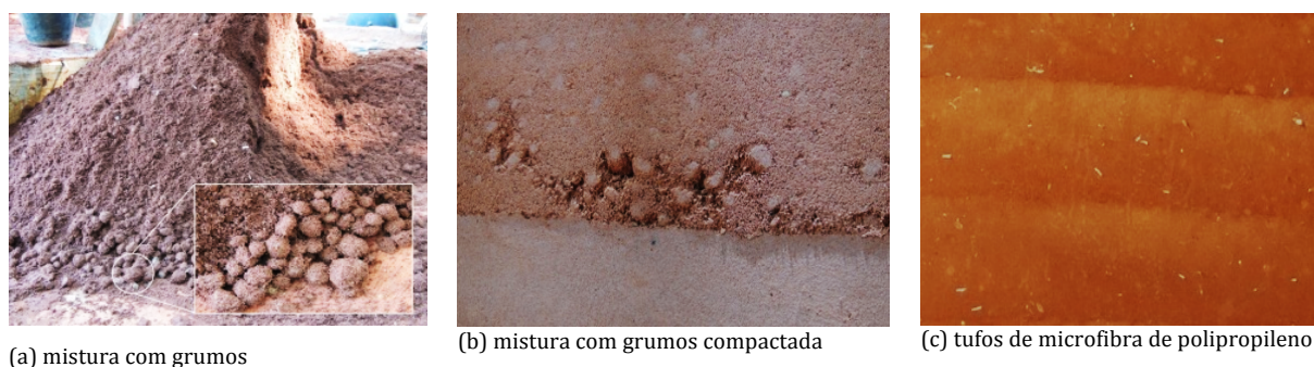
Figura 41: Heterogeneidade na superfície da parede.
