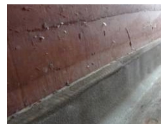
Aparência final da parede externa
