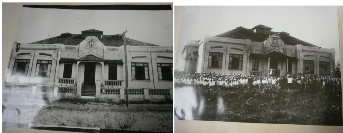
Figura V e VI: Prédio da Escola Normal Joaquim Murtinho.
