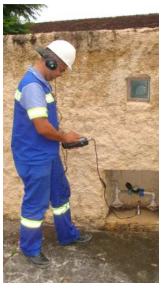
Figura II. 10 - Funcionário utilizando geofone à procura de vazamentos. Foto tirada em 13 de março de 2012.
