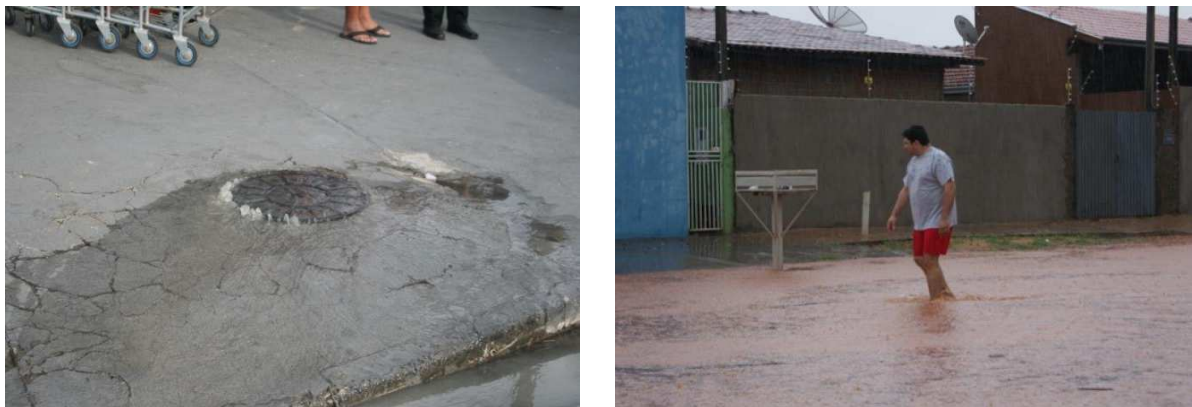
Figura III. 2 - À esquerda, poço de visita de esgoto transbordando na calçada. À direita, rua alagada nas proximidades da Lagoa Maior, em Três lagoas/MS. Fotos tiradas em 13 de fevereiro de 2012.
