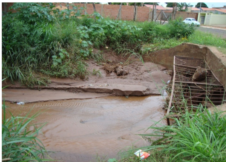
Figura 5.3: Grelha obstruída acumulando grande quantidade de sedimentos
