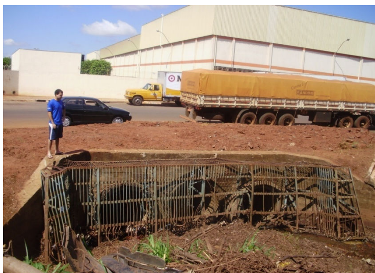
Figura 5.2: Manilhas de concreto na entrada do canal
