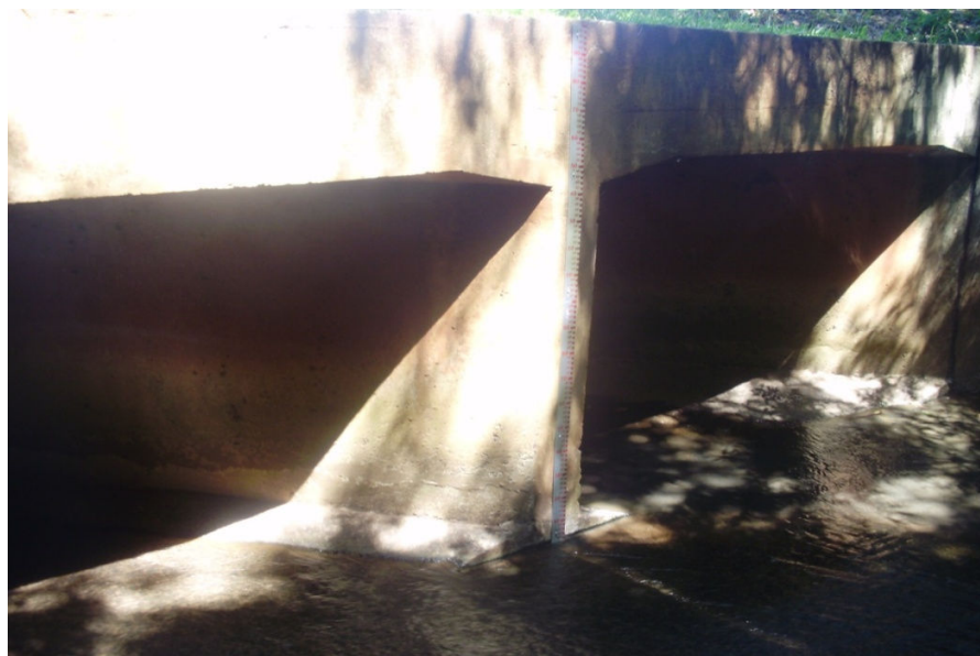
Figura 4.8: Seção de Monitoramento em Bueiro Duplo Celular
