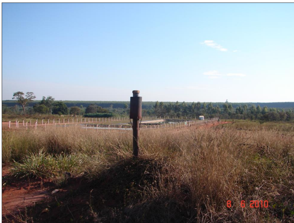
Foto 9 – Dreno de gases gerados no antigo aterro controlado de Três Lagoas -MS
