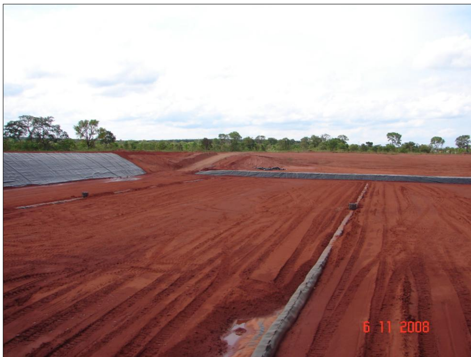
Foto 4 – Construção do sistema de drenagem de percolado da primeira célula do aterro sanitário de Três Lagoas - MS
