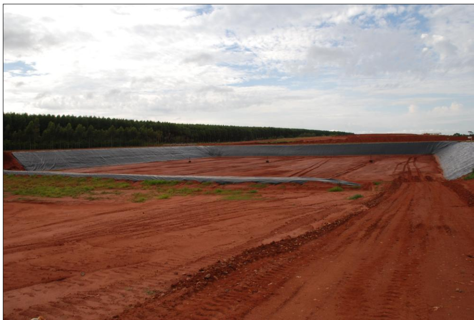
Foto 5 – Fase final da construção da primeira célula do aterro sanitário Três Lagoas – MS com implantação dos drenos de gases
