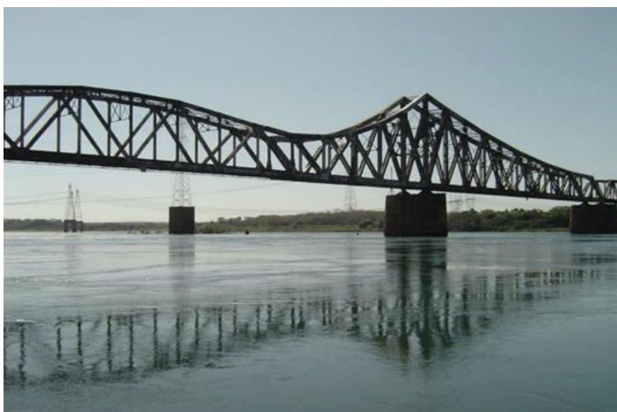
Figura 2: Ponte Ferroviária Francisco de Sá, inaugurada no ano de 1926, ligação dos Estado de São Paulo a Três Lagoas através da Noroeste do Brasil.
