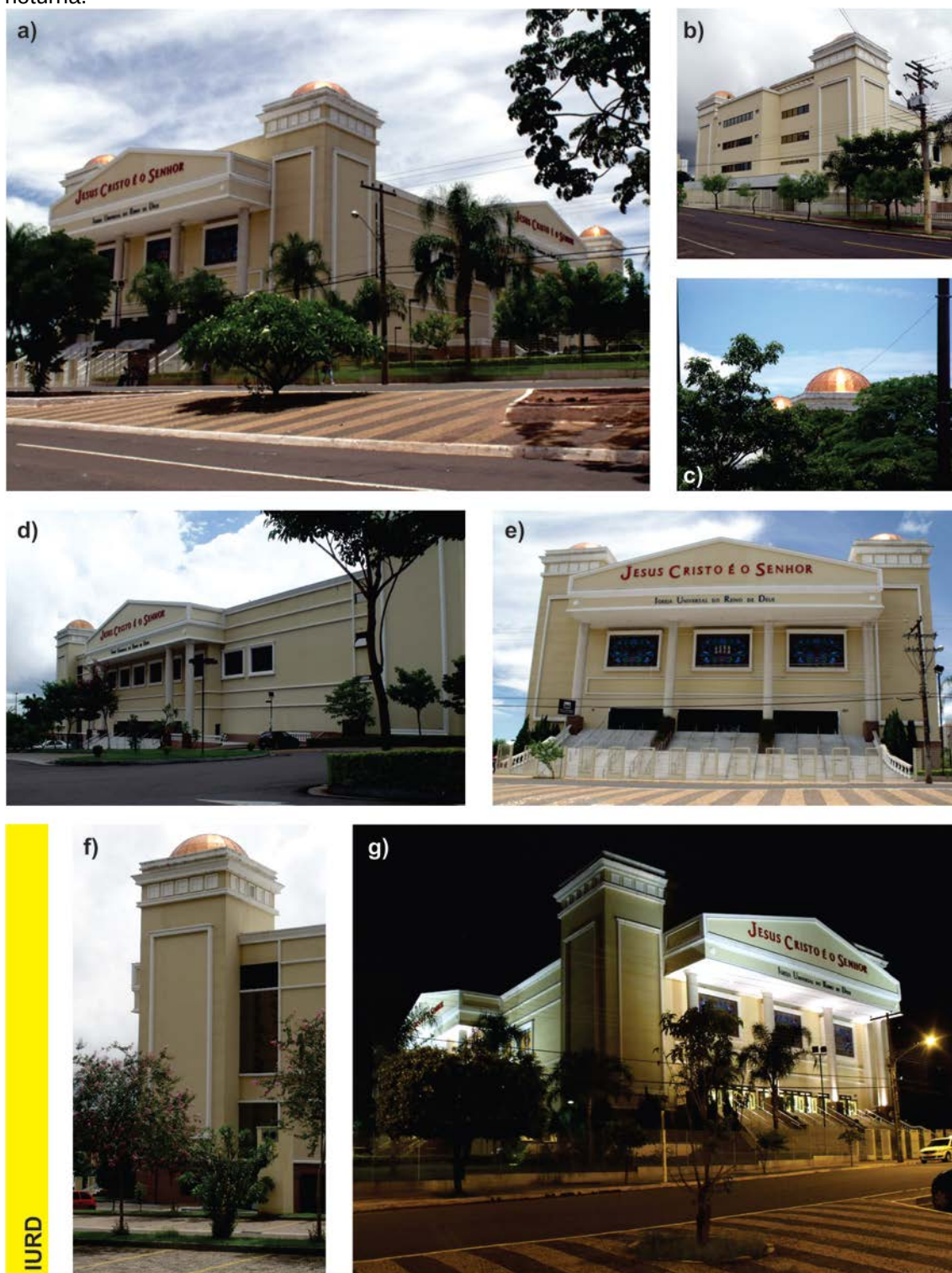
FIGURA 08 – Painel de imagens do templo da IURD: a) Vista geral, Av. Mato Grosso; b) Fachada posterior, Rua Abrão Júlio Rahe; c) Detalhe das cúpulas e copas; d) Vista da Rua José Antônio; e) Fachada sul em destaque; f) Detalhe de uma das quatro torres; g) Vista noturna.
