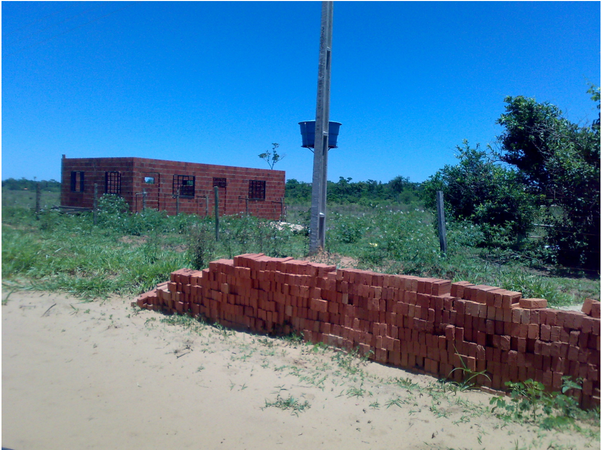
Construções abandonadas no assentamento Bela Manhã (Taquarussu, Novembro de 2010)
