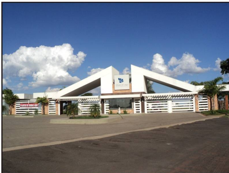
Figura 26: Vista parcial do condomínio Village do Lago. Foto: Patrícia H. Milani; Edima Aranha, 2011
