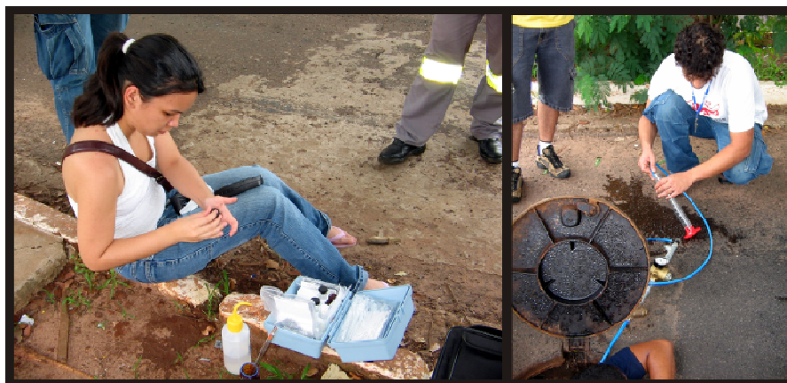
Figura 5.30 - Verificação da concentração de cloro e vazão.
