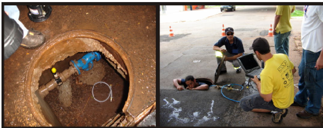
Figura 5.29 - Ponto de instalação da sonda 2.
