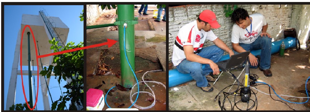
Figura 5.28 - Ponto de instalação da sonda 1 (Setor B).
