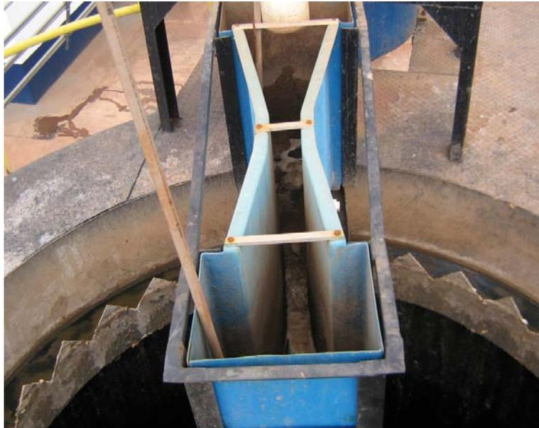
Figura 4.4 – Entrada do decantador – Medidor de Vazão do Tipo Calha Parshall.
