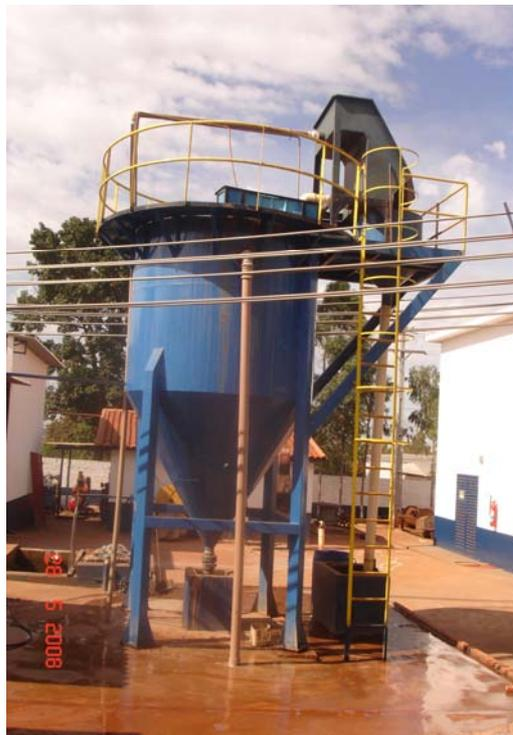
Figura 4.5 – Vista do tanque decantador elevado.
