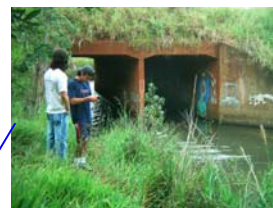
Figura 5.33: Jusante da captação de água, Guariroba
